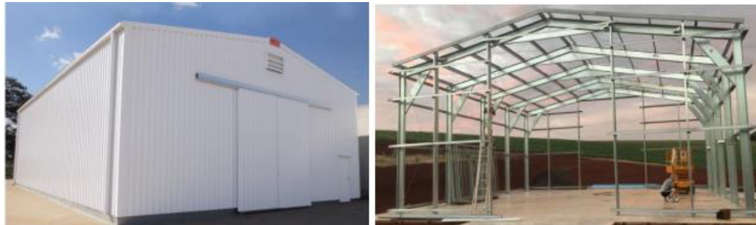
Figura 7 – Galpão com estrutura de aço galvanizado
