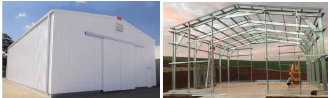
Figura 7 – Galpão com estrutura de aço galvanizado
