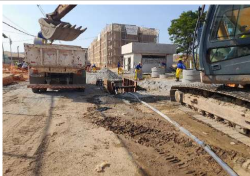
EXECUÇÃO DA REDE DE ESGOTO
