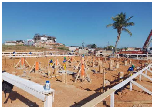
EXECUÇÃO DE ESTRUTURAS DOS BLOCOS DA QUADRA O
