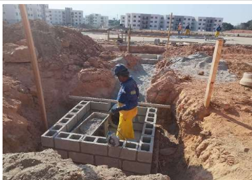
EXECUÇÃO DA REDE DE DRENAGEM
