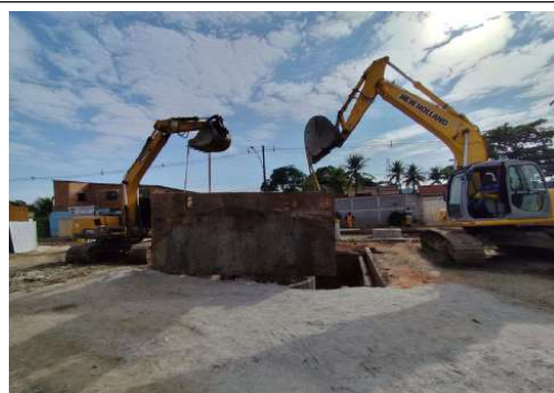
EXECUÇÃO DA ESTAÇÃO ELEVATÓRIA DE ESGOTO
