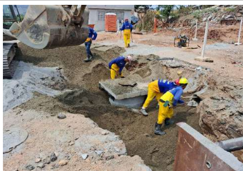
EXECUÇÃO DA REDE DE ESGOTO
