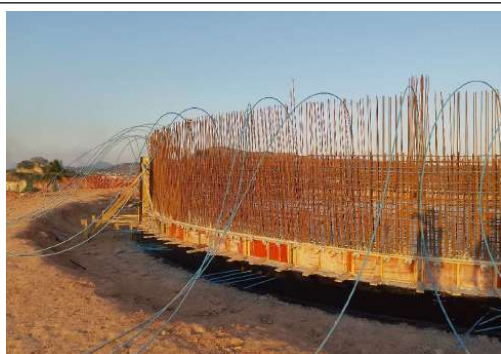
EXECUÇÃO ESTRUTURAL DO RESERVATÓRIO
