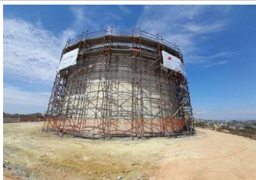
EXECUÇÃO ESTRUTURAL DO RESERVATÓRIO
