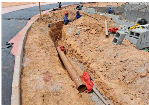
EXECUÇÃO DA REDE DE DRENAGEM
