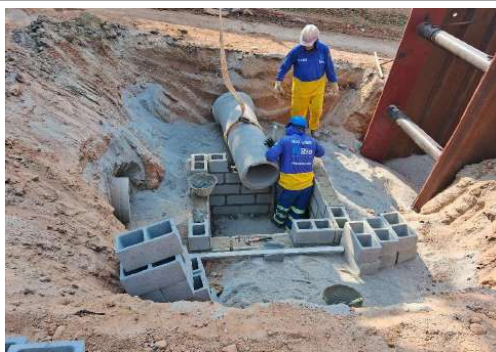
EXECUÇÃO DA REDE DE DRENAGEM
