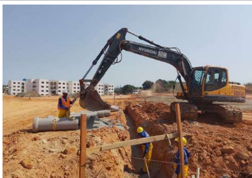
EXECUÇÃO DA REDE DE DRENAGEM
