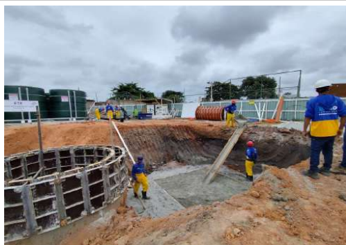
EXECUÇÃO DA ESTAÇÃO ELEVATÓRIA DE ESGOTO
