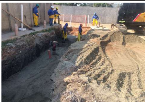
EXECUÇÃO DA REDE DE ESGOTO
