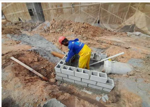
EXECUÇÃO DA REDE DE DRENAGEM
