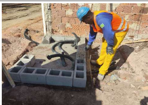
EXECUÇÃO DA ESTAÇÃO ELEVATÓRIA DE ESGOTO
