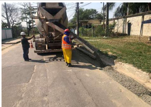
EXECUÇÃO DA REDE DE RECALQUE DO ESGOTO
