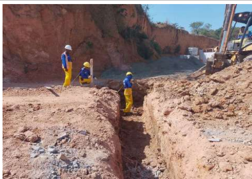
EXECUÇÃO DA REDE DE DRENAGEM
