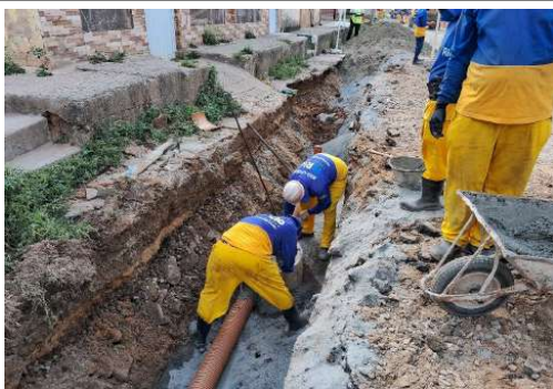
EXECUÇÃO DA REDE DE ESGOTO
