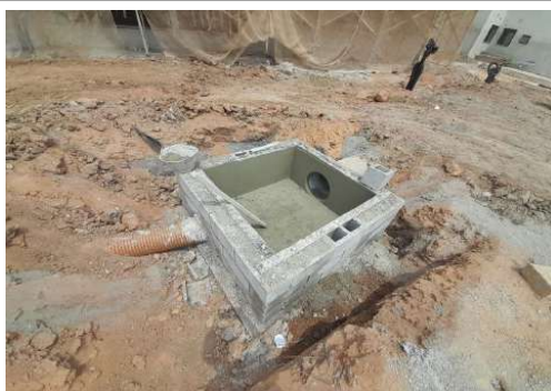
EXECUÇÃO DA REDE DE DRENAGEM
