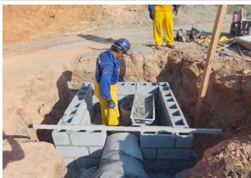
EXECUÇÃO DA REDE DE DRENAGEM
