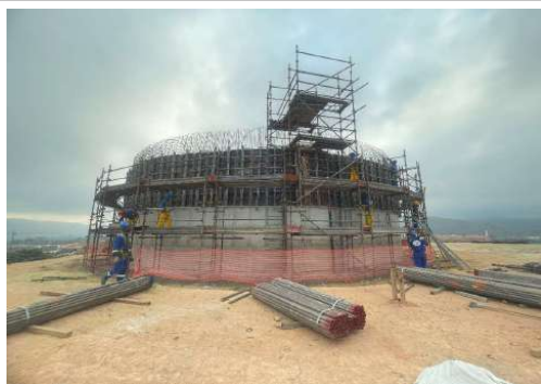
EXECUÇÃO ESTRUTURAL DO RESERVATÓRIO
