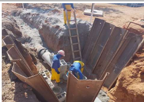
EXECUÇÃO DA REDE DE DRENAGEM
