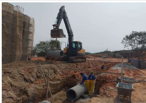
EXECUÇÃO DA REDE DE DRENAGEM
