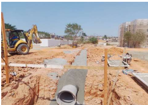
EXECUÇÃO DA REDE DE DRENAGEM
