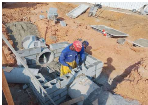
EXECUÇÃO DA REDE DE DRENAGEM
