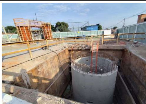
EXECUÇÃO DA ESTAÇÃO ELEVATÓRIA DE ESGOTO
