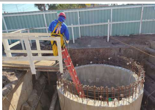
EXECUÇÃO DA ESTAÇÃO ELEVATÓRIA DE ESGOTO
