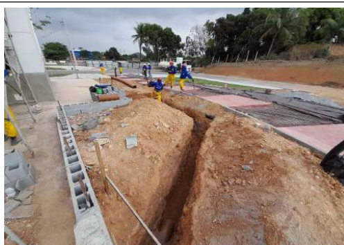
EXECUÇÃO DA REDE DE DRENAGEM
