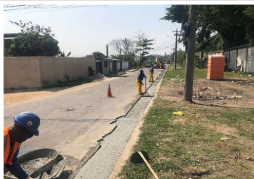
EXECUÇÃO DA REDE DE RECALQUE DO ESGOTO
