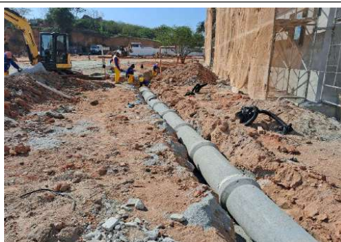
EXECUÇÃO DA REDE DE DRENAGEM
