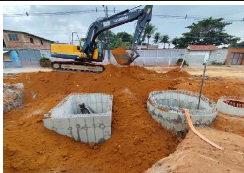
EXECUÇÃO DA ESTAÇÃO ELEVATÓRIA DE ESGOTO
