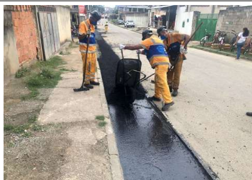
EXECUÇÃO DA REDE DE RECALQUE DO ESGOTO
