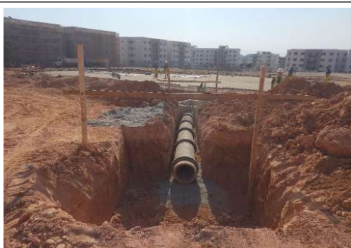
EXECUÇÃO DA REDE DE DRENAGEM
