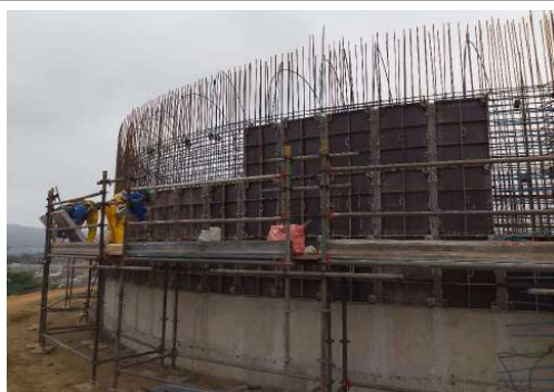
EXECUÇÃO ESTRUTURAL DO RESERVATÓRIO
