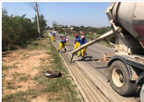
EXECUÇÃO DA REDE DE RECALQUE DO ESGOTO
