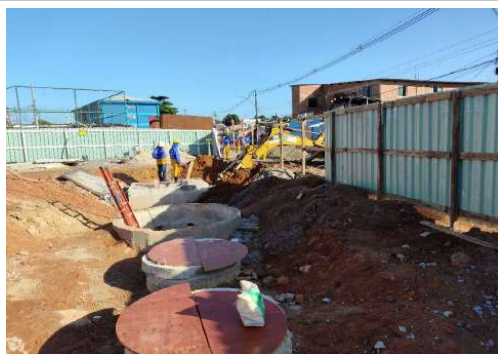
EXECUÇÃO DA ESTAÇÃO ELEVATÓRIA DE ESGOTO
