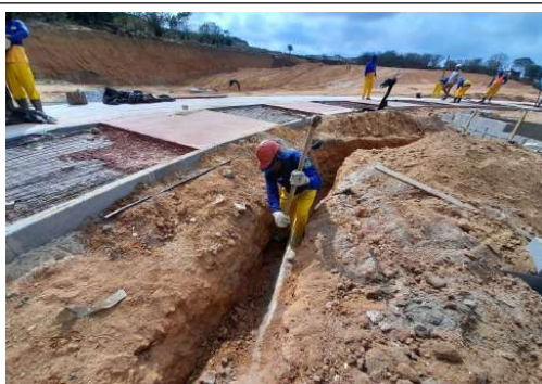
EXECUÇÃO DA REDE DE DRENAGEM
