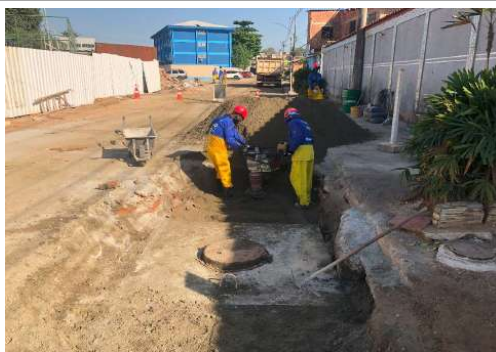
EXECUÇÃO DA REDE DE ESGOTO
