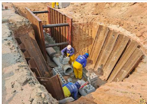
EXECUÇÃO DA REDE DE DRENAGEM
