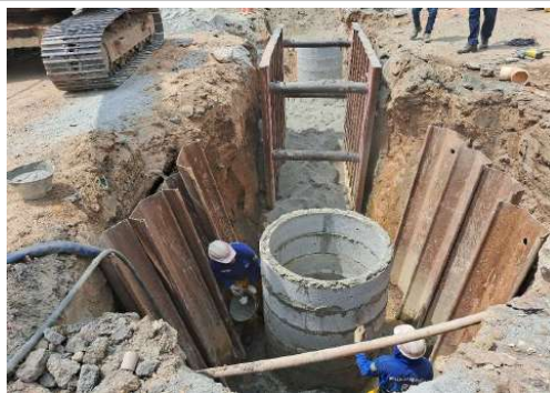
EXECUÇÃO DA REDE DE ESGOTO
