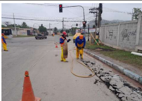
EXECUÇÃO DA REDE DE RECALQUE DO ESGOTO
