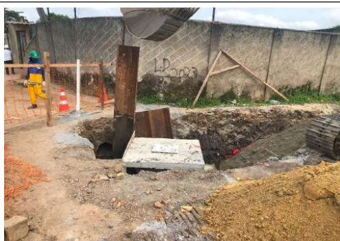
EXECUÇÃO DA REDE DE ESGOTO
