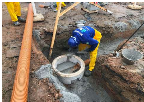
EXECUÇÃO DA REDE DE ESGOTO
