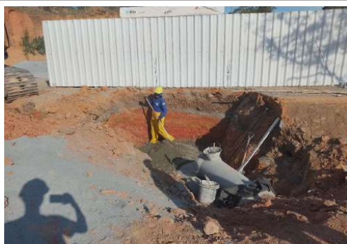
EXECUÇÃO DA REDE DE DRENAGEM
