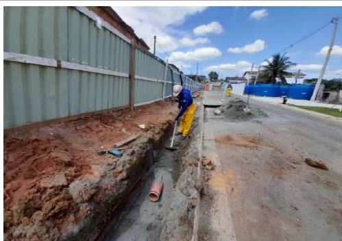
EXECUÇÃO DA REDE DE ESGOTO
