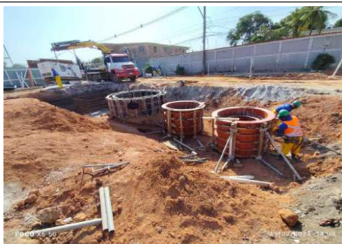
EXECUÇÃO DA ESTAÇÃO ELEVATÓRIA DE ESGOTO
