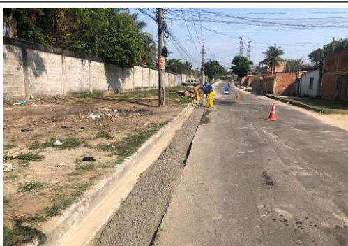
EXECUÇÃO DA REDE DE RECALQUE DO ESGOTO
