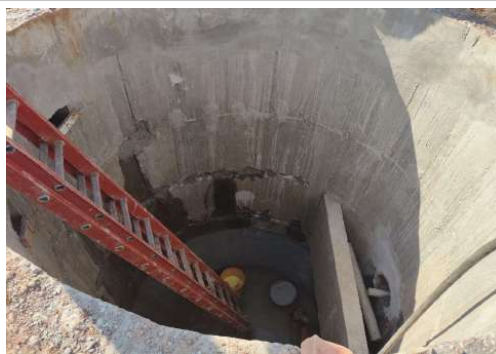
EXECUÇÃO DA ESTAÇÃO ELEVATÓRIA DE ESGOTO
