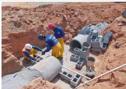
EXECUÇÃO DA REDE DE DRENAGEM
