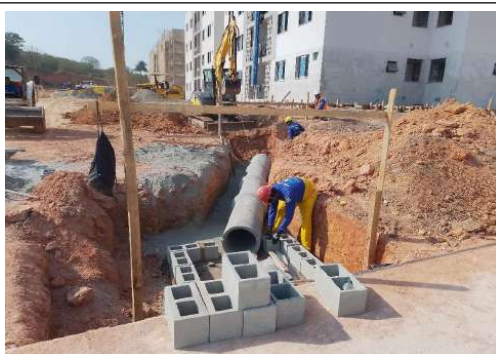
EXECUÇÃO DA REDE DE DRENAGEM
