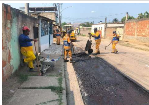
EXECUÇÃO DA REDE DE RECALQUE DO ESGOTO
