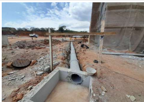
EXECUÇÃO DA REDE DE DRENAGEM
