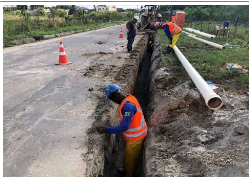
EXECUÇÃO DA REDE DE RECALQUE DO ESGOTO
