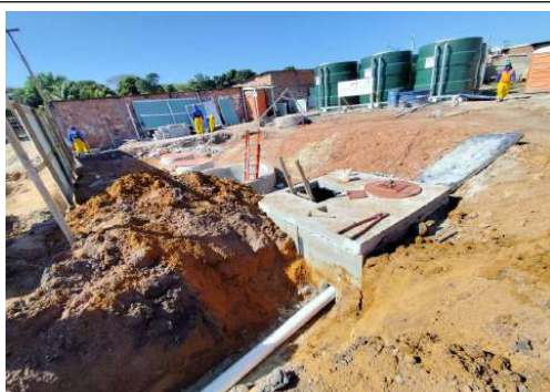
EXECUÇÃO DA ESTAÇÃO ELEVATÓRIA DE ESGOTO
