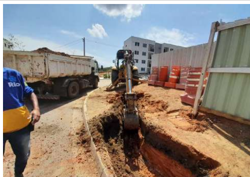
EXECUÇÃO DA REDE DE ESGOTO
