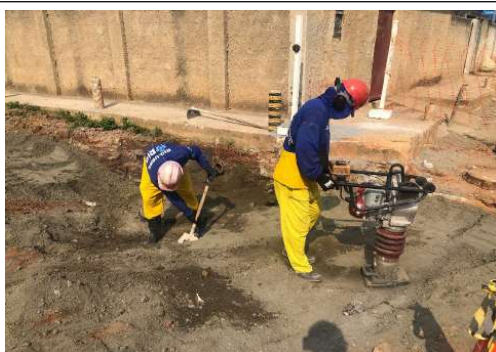
EXECUÇÃO DA REDE DE ESGOTO
