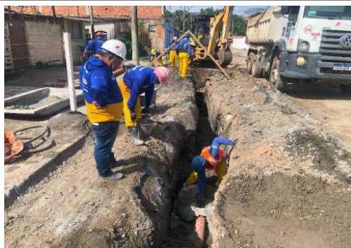
EXECUÇÃO DA REDE DE ESGOTO
