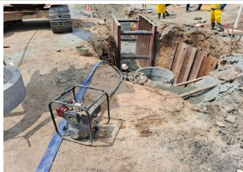
EXECUÇÃO DA REDE DE ESGOTO
