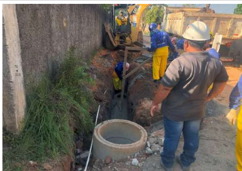
EXECUÇÃO DA REDE DE ESGOTO
