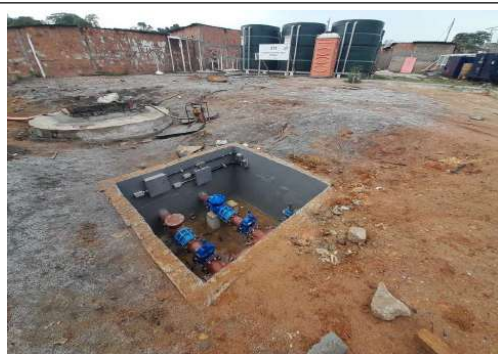
EXECUÇÃO DA ESTAÇÃO ELEVATÓRIA DE ESGOTO
