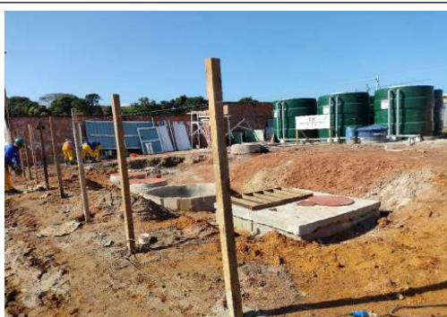
EXECUÇÃO DA ESTAÇÃO ELEVATÓRIA DE ESGOTO
