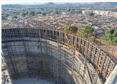
EXECUÇÃO ESTRUTURAL DO RESERVATÓRIO
