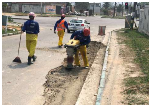
EXECUÇÃO DA REDE DE RECALQUE DO ESGOTO
