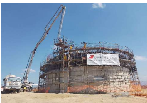
EXECUÇÃO ESTRUTURAL DO RESERVATÓRIO
