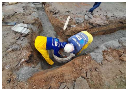
EXECUÇÃO DA REDE DE ESGOTO
