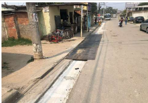
EXECUÇÃO DA REDE DE RECALQUE DO ESGOTO
