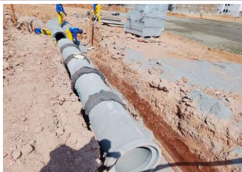
EXECUÇÃO DA REDE DE DRENAGEM
