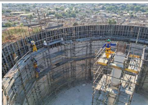
EXECUÇÃO ESTRUTURAL DO RESERVATÓRIO
