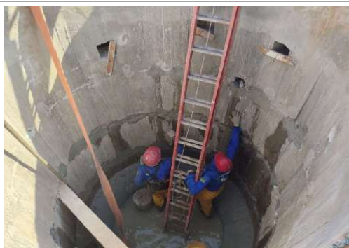
EXECUÇÃO DA ESTAÇÃO ELEVATÓRIA DE ESGOTO
