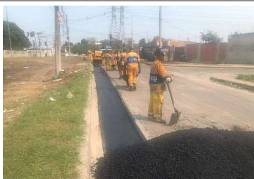
EXECUÇÃO DA REDE DE RECALQUE DO ESGOTO
