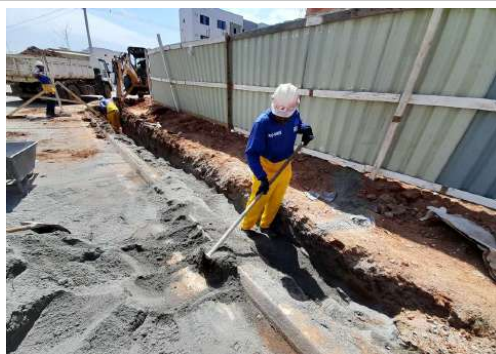
EXECUÇÃO DA REDE DE ESGOTO
