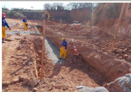
EXECUÇÃO DA REDE DE DRENAGEM
