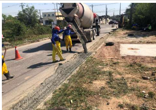
EXECUÇÃO DA REDE DE RECALQUE DO ESGOTO
