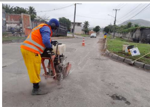
EXECUÇÃO DA REDE DE RECALQUE DO ESGOTO
