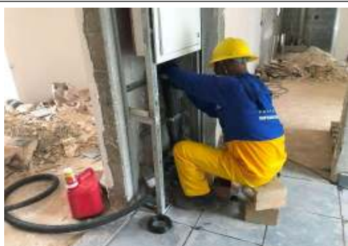
EXECUÇÃO DE INSTALAÇÕES
