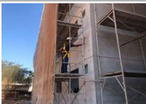
EXECUÇÃO DE REVESTIMENTO
