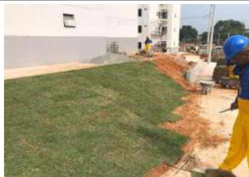
EXECUÇÃO DE URBANIZAÇÃO
