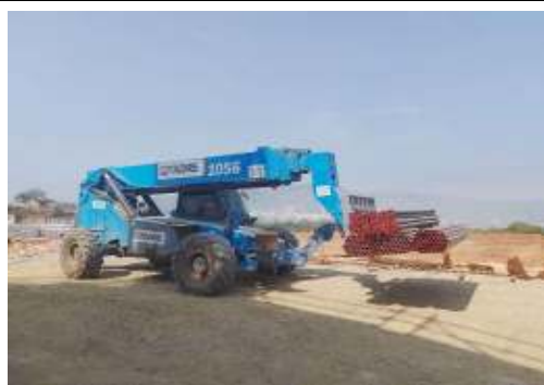
EXECUÇÃO DE SERVIÇOS EXTERNOS
