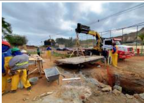
EXECUÇÃO DE SERVIÇOS EXTERNOS
