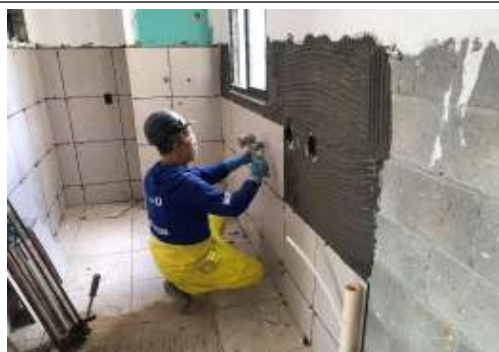
EXECUÇÃO DE SERVIÇOS INTERNOS
