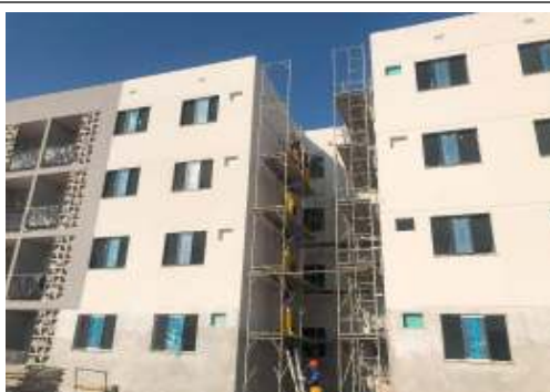
EXECUÇÃO DE ANDAIMES
