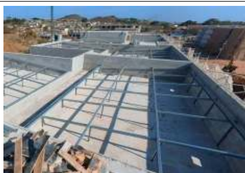
EXECUÇÃO DE COBERTURA
