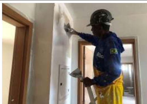
EXECUÇÃO DE REVESTIMENTO
