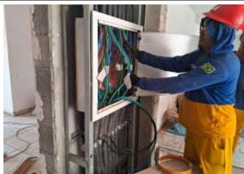
EXECUÇÃO DE INSTALAÇÕES
