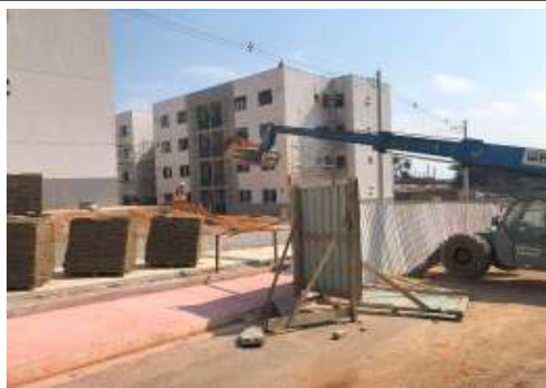
EXECUÇÃO DE URBANIZAÇÃO
