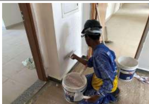
EXECUÇÃO DE REVESTIMENTO
