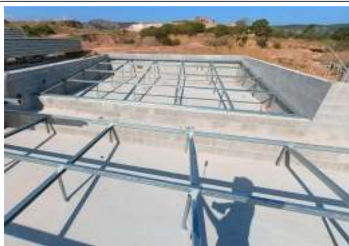
EXECUÇÃO DE COBERTURA
