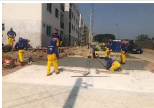
EXECUÇÃO DE URBANIZAÇÃO
