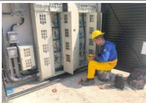
EXECUÇÃO DE INSTALAÇÕES
