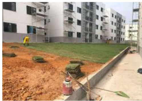
EXECUÇÃO DE URBANIZAÇÃO
