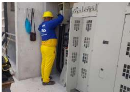
EXECUÇÃO DE INSTALAÇÕES
