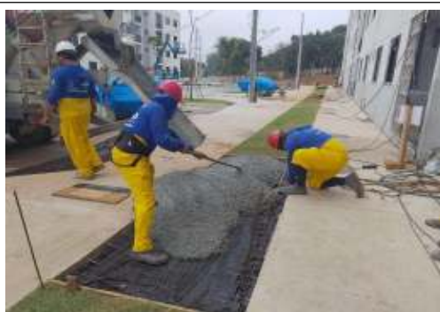
EXECUÇÃO DE URBANIZAÇÃO
