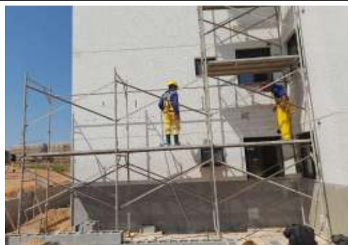
EXECUÇÃO DE ANDAIME
