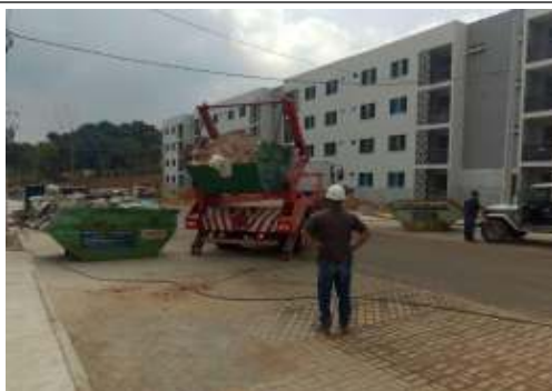
RETIRADA DE RESÍDUOS EM CAÇAMBAS
