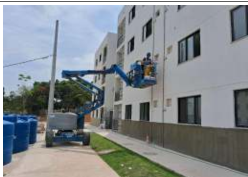
EXECUÇÃO DE SERVIÇOS EXTERNOS
