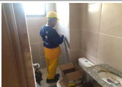
EXECUÇÃO DE SERVIÇOS INTERNOS
