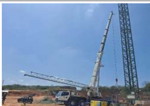
DESMOBILIZAÇÃO E MOBILIZAÇÃO DA GRUA
