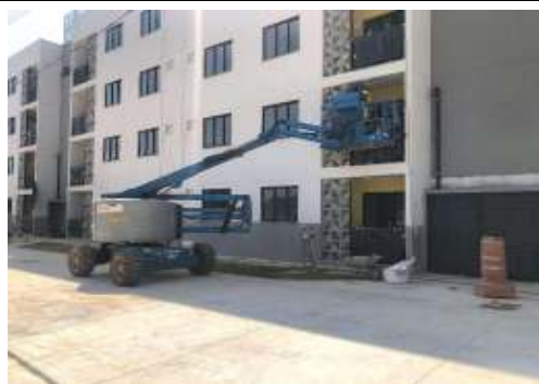
EXECUÇÃO DE SERVIÇOS EXTERNOS
