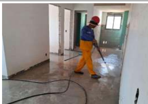
EXECUÇÃO DE SERVIÇOS INTERNOS
