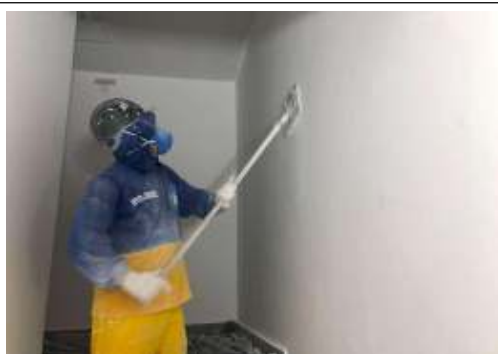
EXECUÇÃO DE SERVIÇOS INTERNOS
