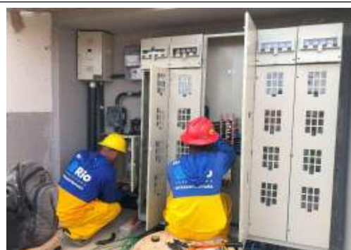
EXECUÇÃO DE INSTALAÇÕES
