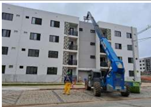
EXECUÇÃO DE SERVIÇOS EXTERNOS
