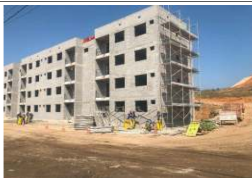
EXECUÇÃO DE ANDAIMES
