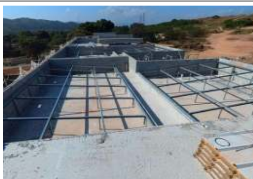
EXECUÇÃO DE COBERTURA
