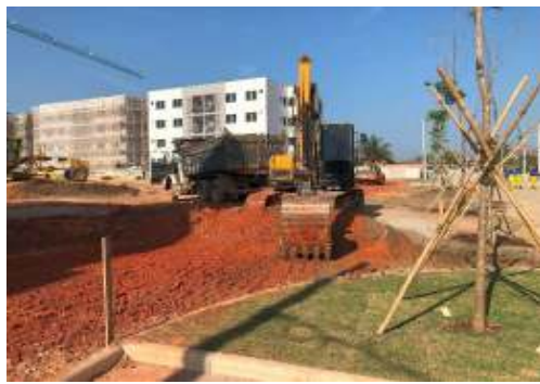
EXECUÇÃO DE URBANIZAÇÃO
