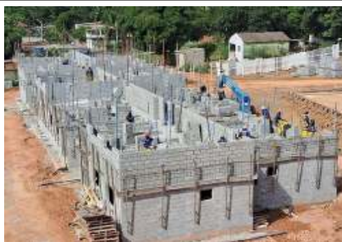
EXECUÇÃO DE ESTRUTURAS
