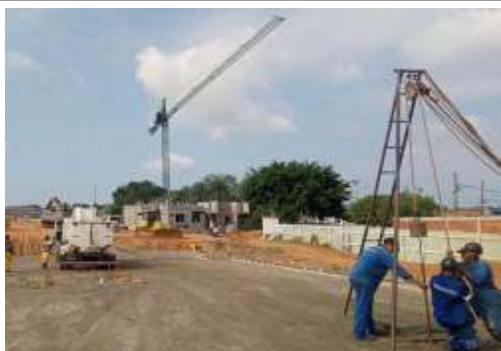
EXECUÇÃO DE FUNDAÇÃO DA GRUA
