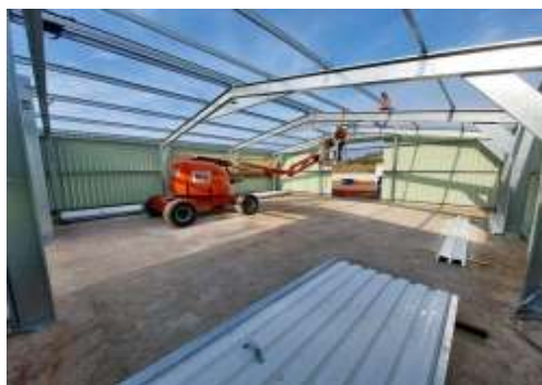
CANTEIRO PRINCIPAL - GALPÃO METÁLICO
