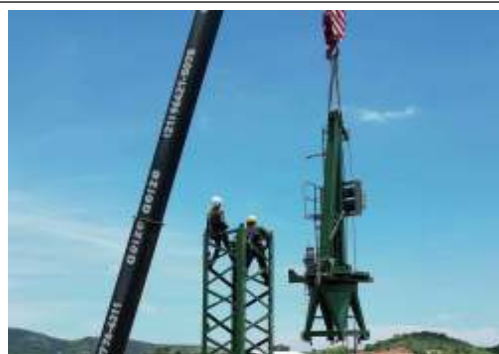
DESMOBILIZAÇÃO E MOBILIZAÇÃO DE GRUA
