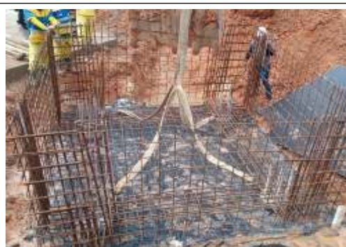
EXECUÇÃO DE FUNDAÇÃO DA GRUA
