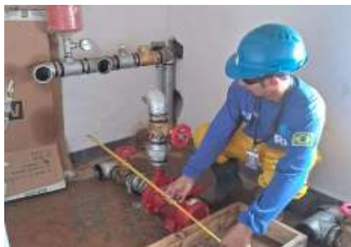
EXECUÇÃO DE INSTALAÇÕES
