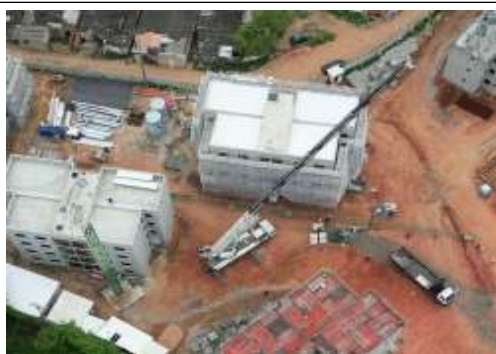
DESMOBILIZAÇÃO E MOBILIZAÇÃO DE GRUA
