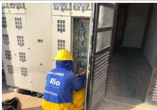
EXECUÇÃO DE INSTALAÇÕES
