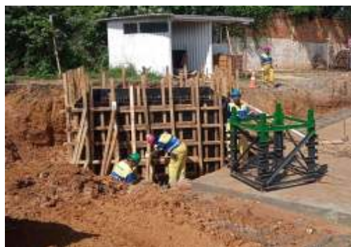
EXECUÇÃO DE FUNDAÇÃO DA GRUA
