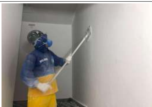
EXECUÇÃO DE REVESTIMENTO
