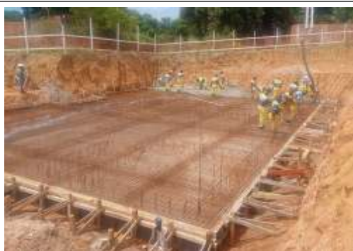
EXECUÇÃO DE ESTRUTURAS
