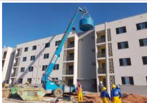
EXECUÇÃO DE SERVIÇOS EXTERNOS
