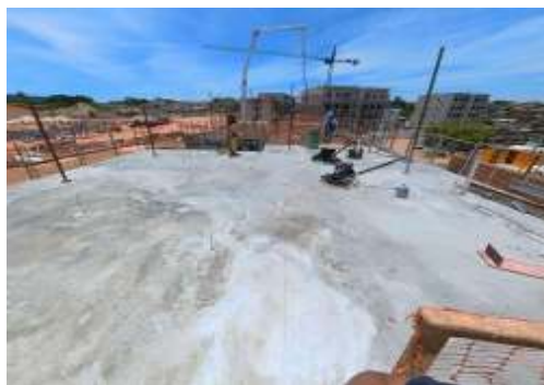
EXECUÇÃO DE ESTRUTURAS
