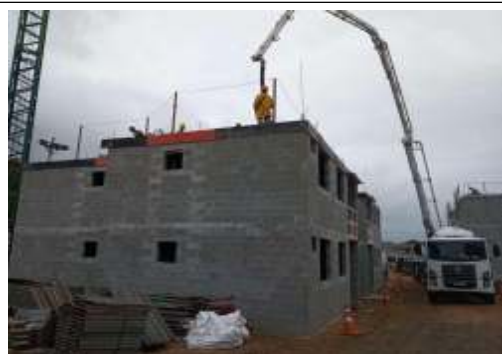
EXECUÇÃO DE ESTRUTURAS
