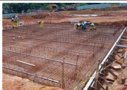
EXECUÇÃO DE ESTRUTURAS
