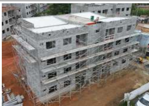
EXECUÇÃO DE ANDAIME
