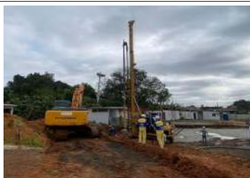
EXECUÇÃO DE FUNDAÇÃO DA GRUA
