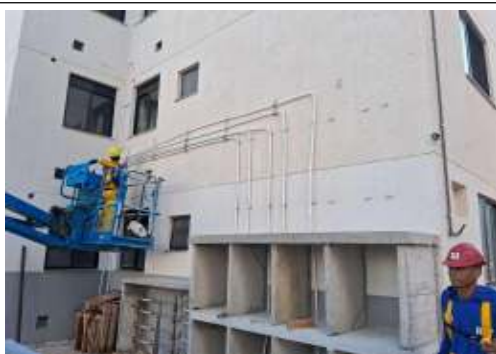
EXECUÇÃO DE INSTALAÇÕES
