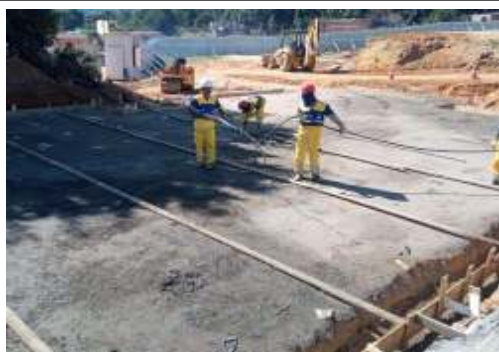
EXECUÇÃO DE ESTRUTURAS
