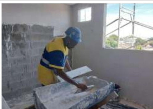
EXECUÇÃO DE REVESTIMENTO
