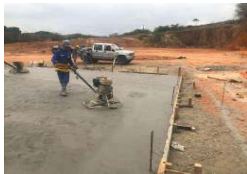
EXECUÇÃO DE SERVIÇOS EXTERNOS
