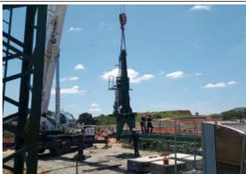
EXECUÇÃO MONTAGEM DA GRUA
