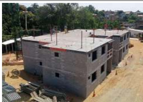
EXECUÇÃO DE ESTRUTURAS
