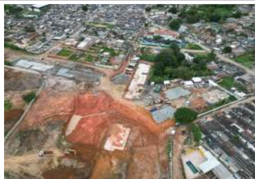
EXECUÇÃO DE REPARO NO SOLO
