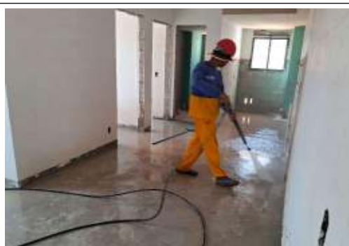
EXECUÇÃO DE SERVIÇOS INTERNOS
