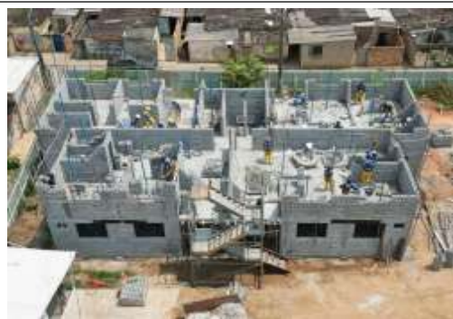
EXECUÇÃO DE ESTRUTURAS
