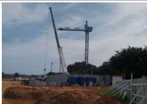
EXECUÇÃO MONTAGEM DA GRUA
