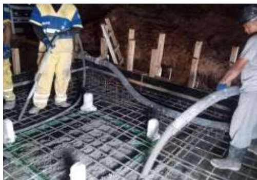
EXECUÇÃO DE FUNDAÇÃO DA GRUA
