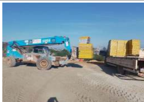
EXECUÇÃO DO RESERVATÓRIO
