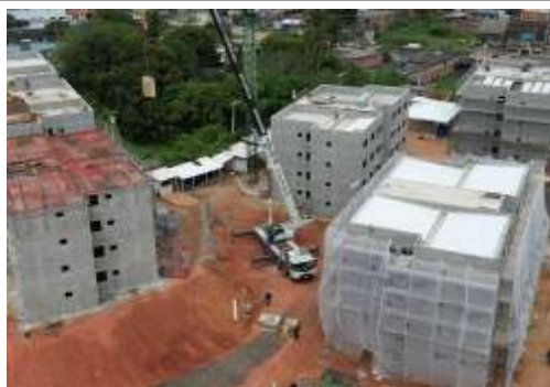
DESMOBILIZAÇÃO E MOBILIZAÇÃO DE GRUA
