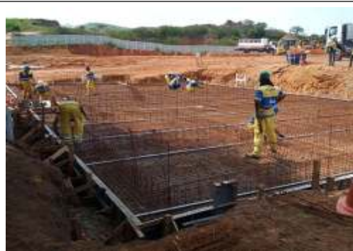
EXECUÇÃO DE ESTRUTURAS
