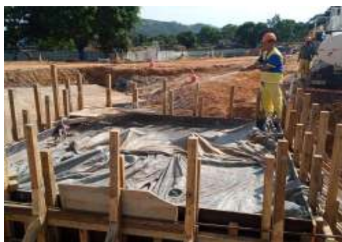
EXECUÇÃO DE FUNDAÇÃO DA GRUA
