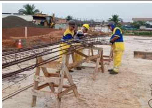
EXECUÇÃO DE FUNDAÇÃO DA GRUA
