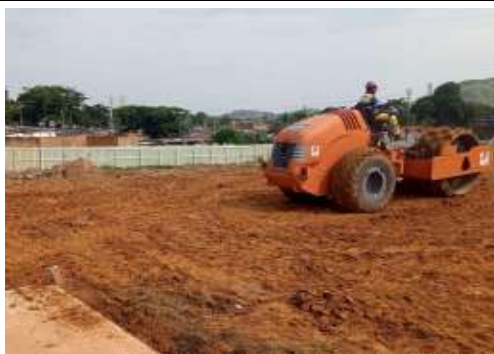
EXECUÇÃO DE REPARO NO SOLO
