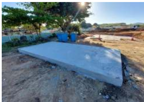
EXECUÇÃO DE BASE DOS SILOS DE ARGAMASSA
