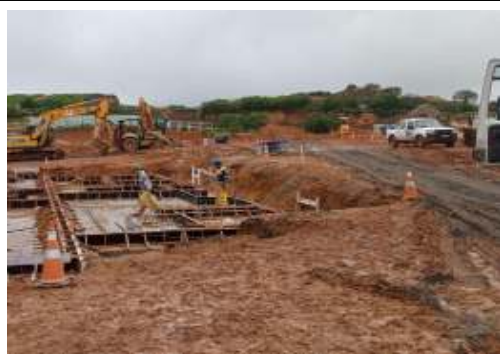
EXECUÇÃO DE REPARO NO SOLO
