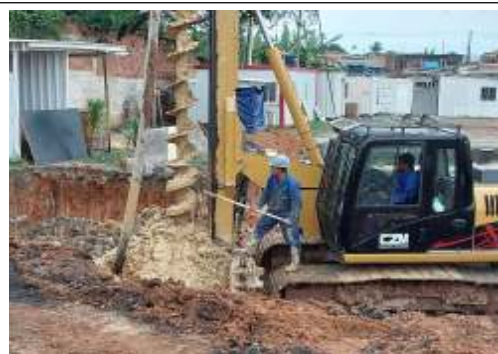
EXECUÇÃO DE FUNDAÇÃO DA GRUA
