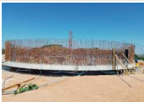
EXECUÇÃO DO RESERVATÓRIO
