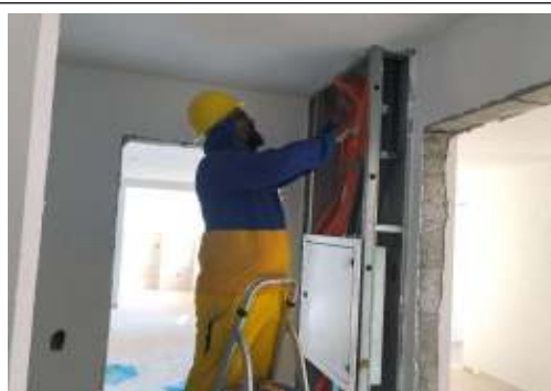
EXECUÇÃO DE INSTALAÇÕES
