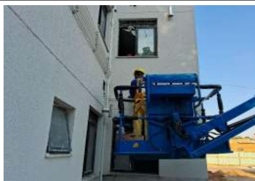
EXECUÇÃO DE SERVIÇOS INTERNOS
