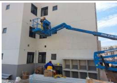
EXECUÇÃO DE INSTALAÇÕES
