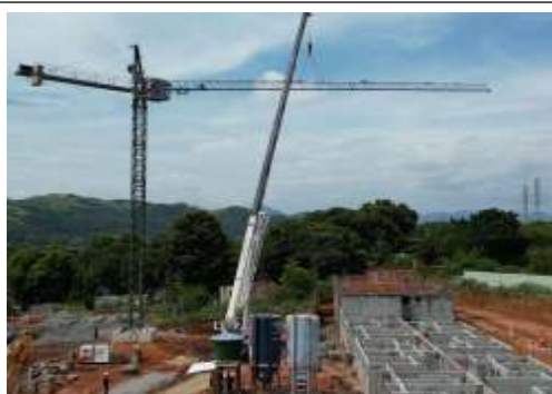
DESMOBILIZAÇÃO E MOBILIZAÇÃO DE GRUA
