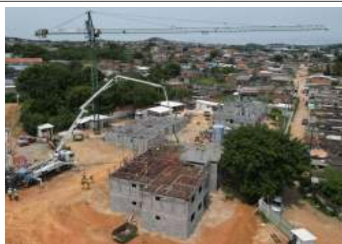
EXECUÇÃO DE ESTRUTURAS
