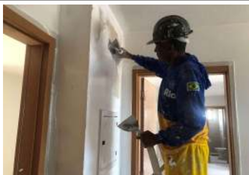
EXECUÇÃO DE REVESTIMENTO
