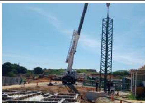
EXECUÇÃO MONTAGEM DA GRUA
