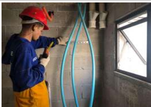
EXECUÇÃO DE INSTALAÇÕES
