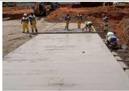
EXECUÇÃO DE ESTRUTURAS
