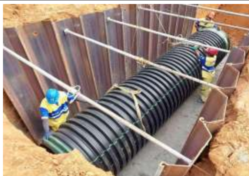
EXECUÇÃO DE REDE DE DRENAGEM
