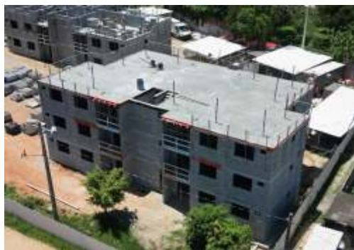
EXECUÇÃO DE ESTRUTURAS
