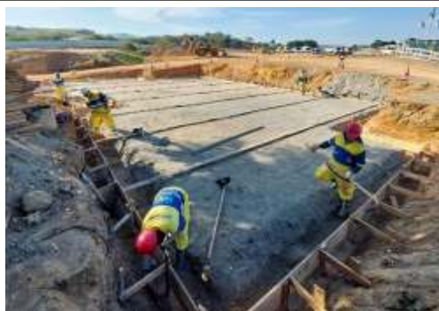
EXECUÇÃO DE ESTRUTURAS
