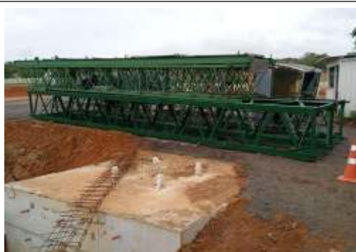
EXECUÇÃO MONTAGEM DA GRUA
