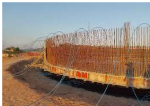
EXECUÇÃO DO RESERVATÓRIO
