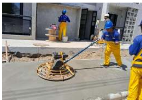
EXECUÇÃO DE SERVIÇOS EXTERNOS
