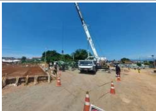
EXECUÇÃO MONTAGEM DA GRUA
