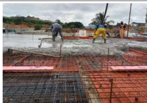
EXECUÇÃO DE ESTRUTURAS
