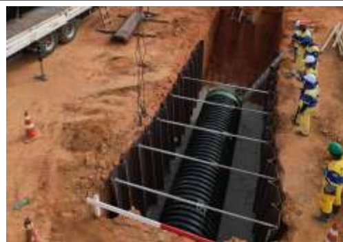
EXECUÇÃO DE REDE DE DRENAGEM
