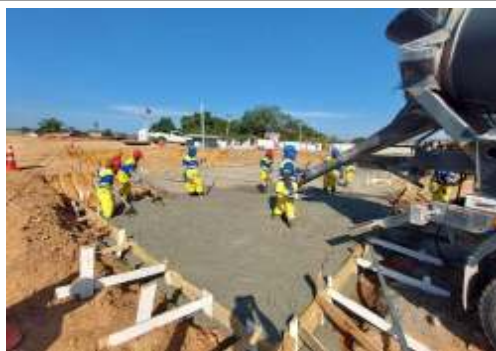
EXECUÇÃO DE ESTRUTURAS
