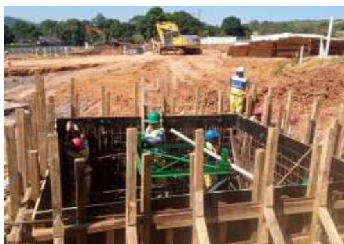
EXECUÇÃO DE FUNDAÇÃO DA GRUA
