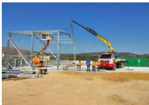
CANTEIRO PRINCIPAL - GALPÃO METÁLICO
