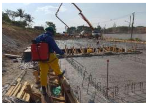
EXECUÇÃO DE ESTRUTURAS
