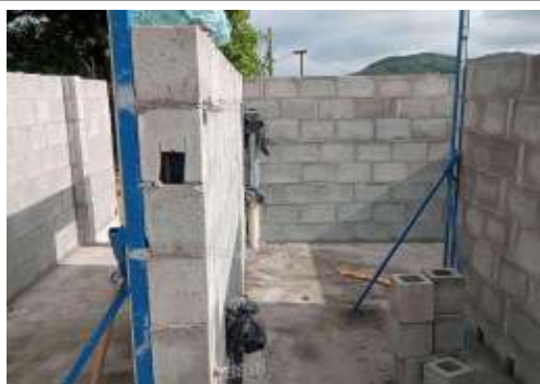
EXECUÇÃO DE ESTRUTURAS
