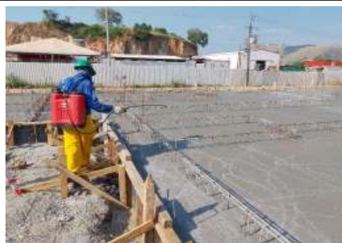
EXECUÇÃO DE ESTRUTURAS
