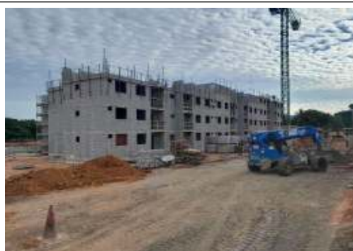
EXECUÇÃO DE ESTRUTURAS
