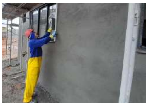
EXECUÇÃO DE REVESTIMENTO
