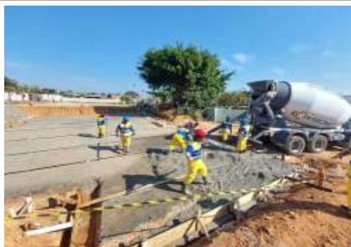
EXECUÇÃO DE ESTRUTURAS
