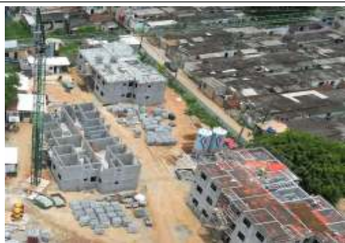
EXECUÇÃO DE ESTRUTURAS
