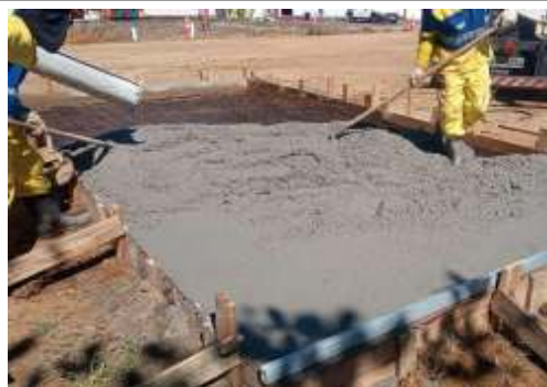
EXECUÇÃO DE BASE DOS SILOS DE ARGAMASSA
