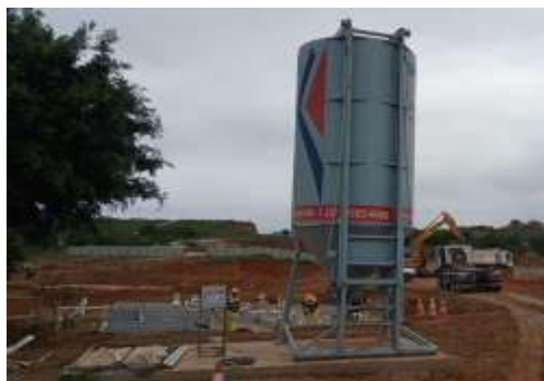
EXECUÇÃO DE BASE DOS SILOS DE ARGAMASSA
