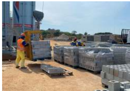
EXECUÇÃO DE ESTRUTURAS
