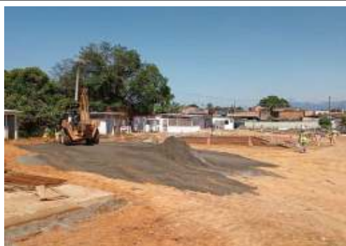
EXECUÇÃO DE REPARO NO SOLO
