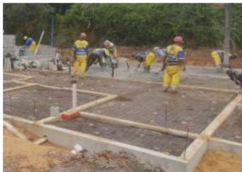
EXECUÇÃO DE ESTRUTURAS
