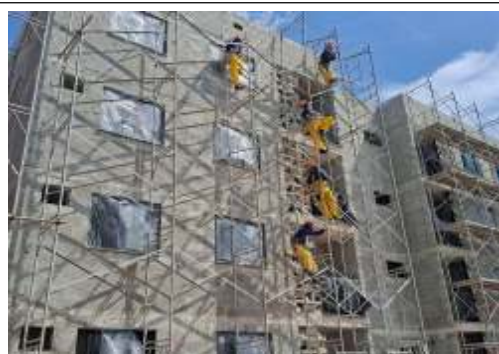
EXECUÇÃO DE ANDAIME
