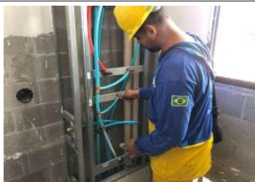
EXECUÇÃO DE INSTALAÇÕES
