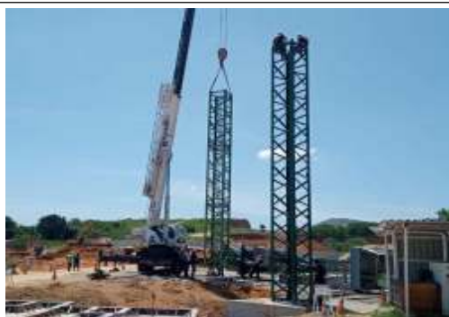
EXECUÇÃO MONTAGEM DA GRUA
