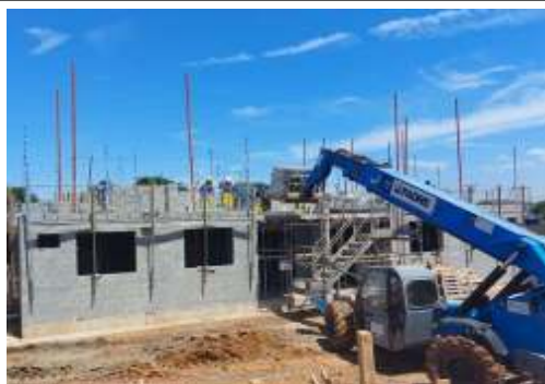
EXECUÇÃO DE ESTRUTURAS
