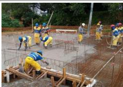
EXECUÇÃO DE ESTRUTURAS
