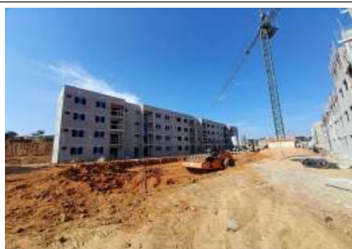
EXECUÇÃO DE ESTRUTURAS
