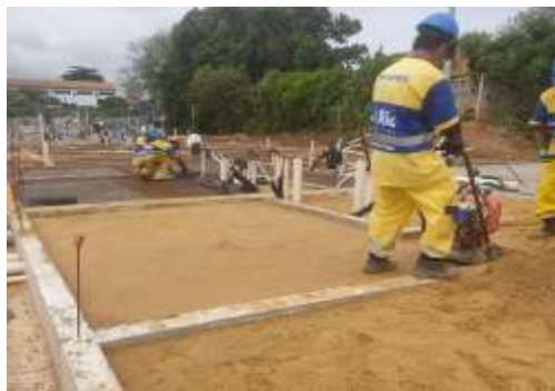
EXECUÇÃO DE ESTRUTURAS
