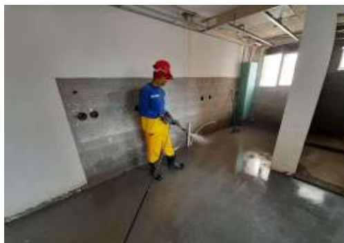
EXECUÇÃO DE SERVIÇOS INTERNOS
