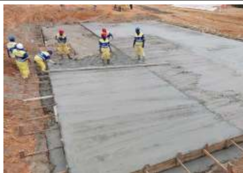
EXECUÇÃO DE ESTRUTURAS
