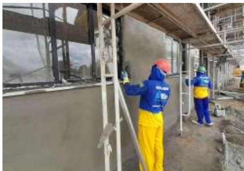
EXECUÇÃO DE REVESTIMENTO
