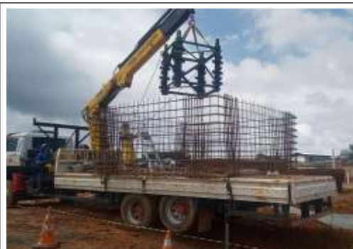
EXECUÇÃO DE FUNDAÇÃO DA GRUA
