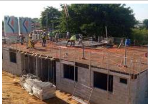
EXECUÇÃO DE ESTRUTURAS
