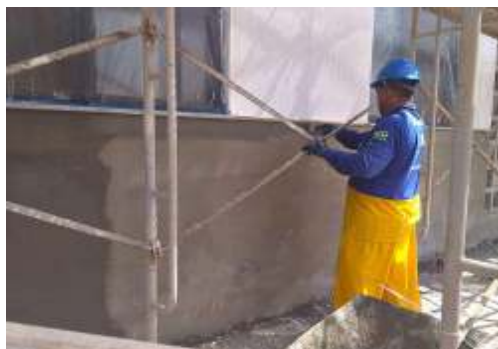
EXECUÇÃO DE REVESTIMENTO
