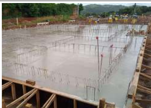
EXECUÇÃO DE ESTRUTURAS
