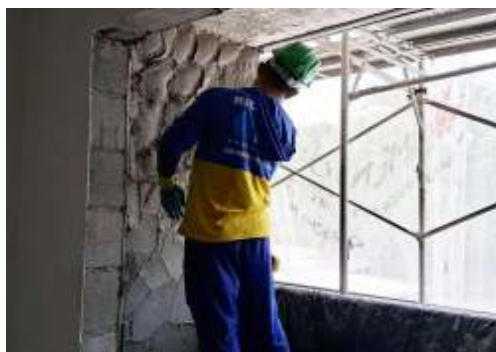
EXECUÇÃO DE REVESTIMENTO
