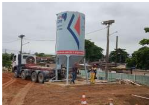
EXECUÇÃO DE BASE DOS SILOS DE ARGAMASSA
