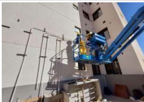
EXECUÇÃO DE INSTALAÇÕES
