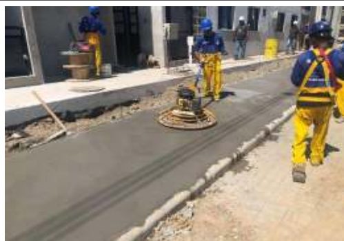
EXECUÇÃO DE SERVIÇOS EXTERNOS
