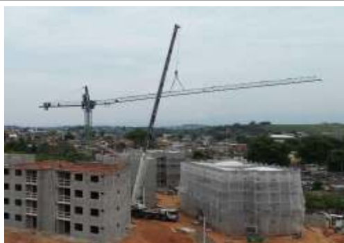
DESMOBILIZAÇÃO E MOBILIZAÇÃO DE GRUA
