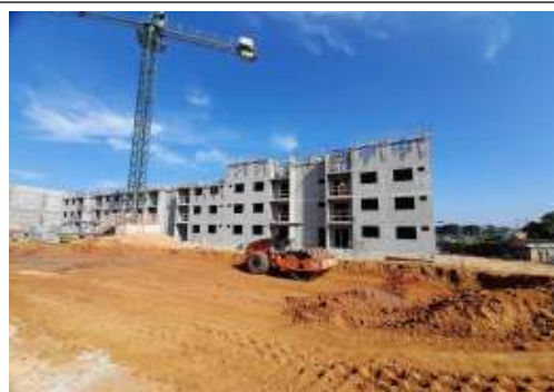
EXECUÇÃO DE ESTRUTURAS
