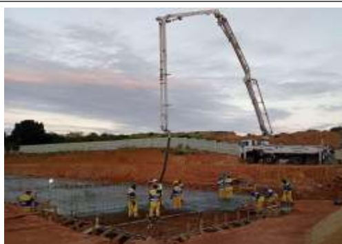
EXECUÇÃO DE ESTRUTURAS
