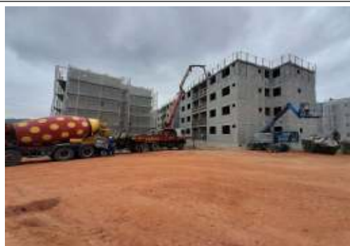
EXECUÇÃO DE ESTRUTURAS
