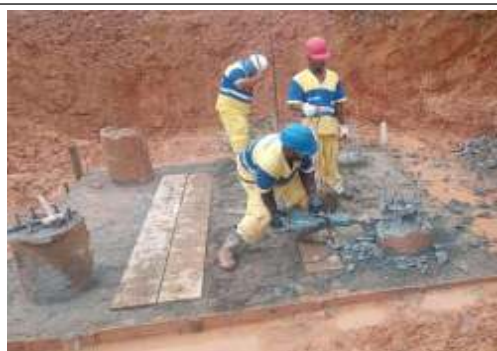
EXECUÇÃO DE FUNDAÇÃO DA GRUA
