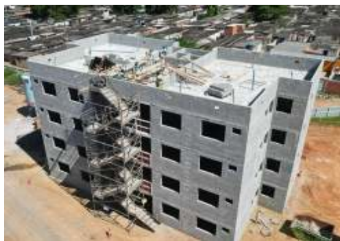
EXECUÇÃO DE ESTRUTURAS
