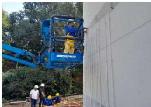
EXECUÇÃO DE INSTALAÇÕES
