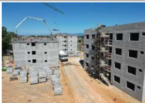
EXECUÇÃO DE ESTRUTURAS
