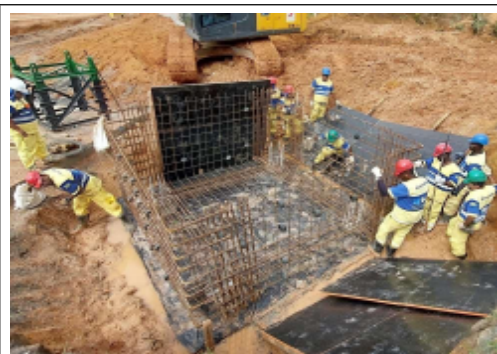
EXECUÇÃO DE FUNDAÇÃO DA GRUA
