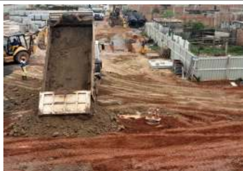
EXECUÇÃO DE REPARO NO SOLO
