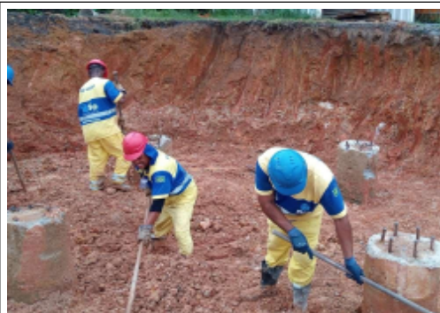
EXECUÇÃO DE FUNDAÇÃO DA GRUA
