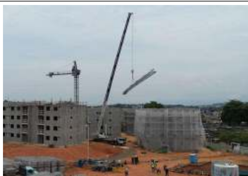
DESMOBILIZAÇÃO E MOBILIZAÇÃO DE GRUA
