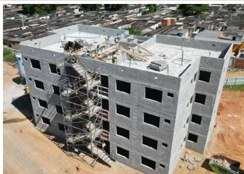
EXECUÇÃO DE ESTRUTURAS
