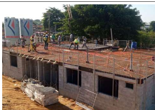
EXECUÇÃO DE ESTRUTURAS
