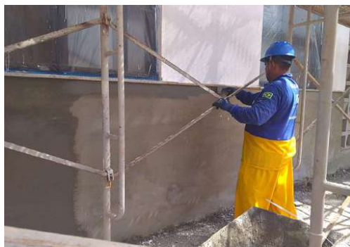
EXECUÇÃO DE REVESTIMENTO
