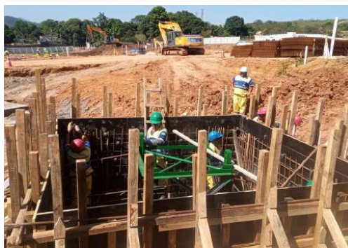
EXECUÇÃO DE FUNDAÇÃO DA GRUA
