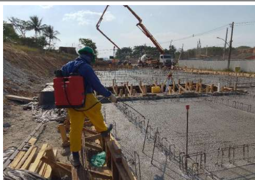
EXECUÇÃO DE ESTRUTURAS
