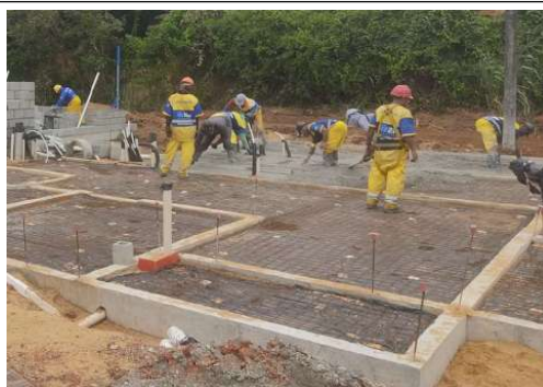
EXECUÇÃO DE ESTRUTURAS
