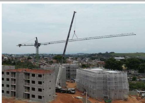
DESMOBILIZAÇÃO E MOBILIZAÇÃO DE GRUA
