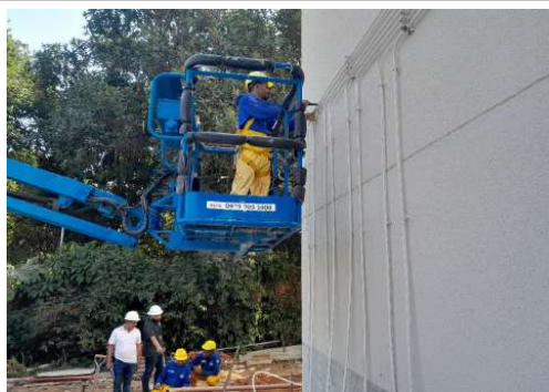
EXECUÇÃO DE INSTALAÇÕES
