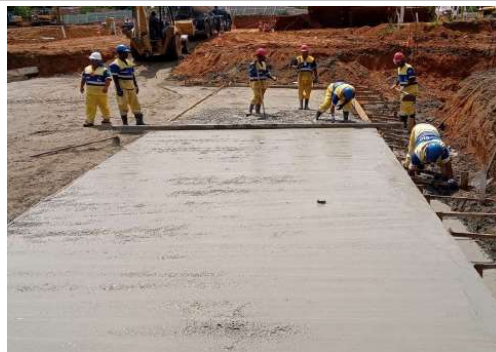
EXECUÇÃO DE ESTRUTURAS
