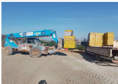
EXECUÇÃO DO RESERVATÓRIO
