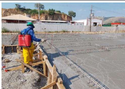
EXECUÇÃO DE ESTRUTURAS
