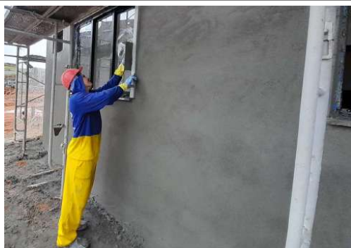
EXECUÇÃO DE REVESTIMENTO
