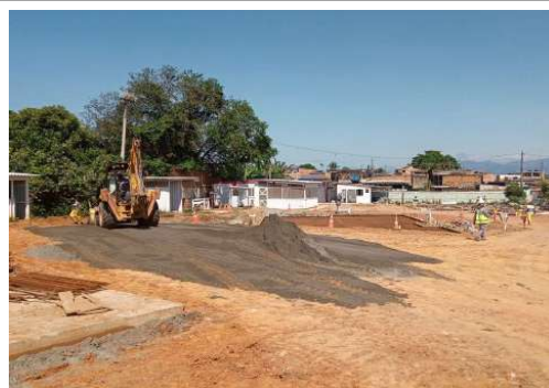
EXECUÇÃO DE REPARO NO SOLO
