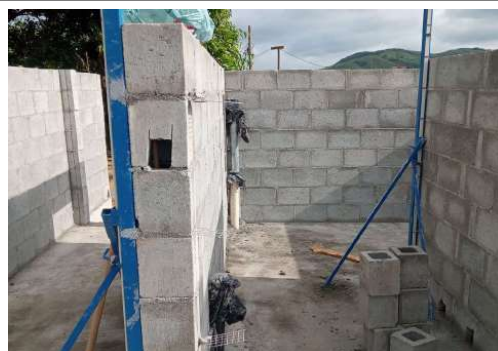
EXECUÇÃO DE ESTRUTURAS
