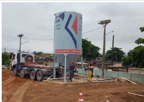
EXECUÇÃO DE BASE DOS SILOS DE ARGAMASSA
