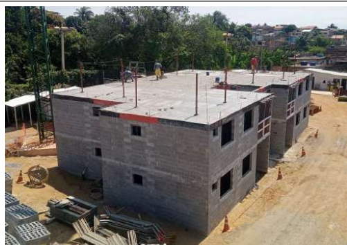
EXECUÇÃO DE ESTRUTURAS
