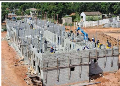
EXECUÇÃO DE ESTRUTURAS
