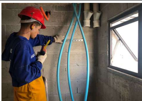
EXECUÇÃO DE INSTALAÇÕES
