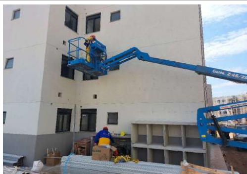
EXECUÇÃO DE INSTALAÇÕES
