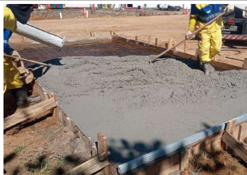
EXECUÇÃO DE BASE DOS SILOS DE ARGAMASSA
