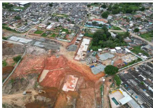
EXECUÇÃO DE REPARO NO SOLO
