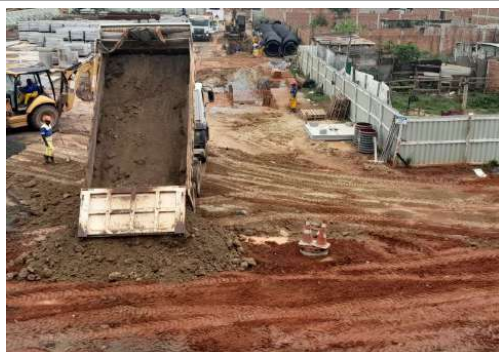
EXECUÇÃO DE REPARO NO SOLO
