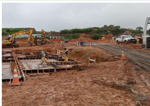
EXECUÇÃO DE REPARO NO SOLO
