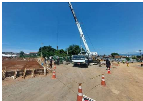
EXECUÇÃO MONTAGEM DA GRUA
