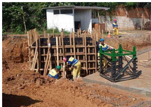
EXECUÇÃO DE FUNDAÇÃO DA GRUA
