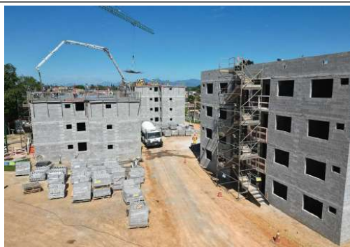
EXECUÇÃO DE ESTRUTURAS
