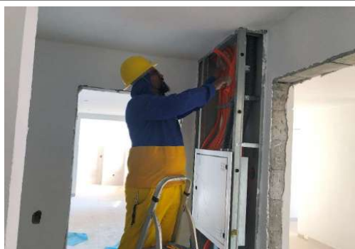
EXECUÇÃO DE INSTALAÇÕES
