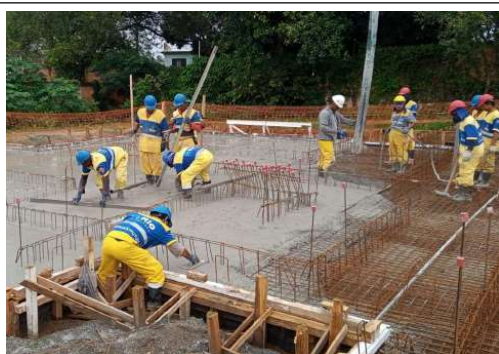
EXECUÇÃO DE ESTRUTURAS
