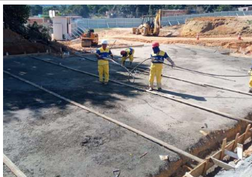
EXECUÇÃO DE ESTRUTURAS
