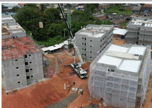
DESMOBILIZAÇÃO E MOBILIZAÇÃO DE GRUA
