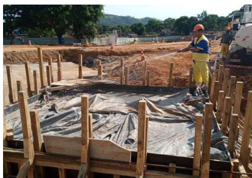
EXECUÇÃO DE FUNDAÇÃO DA GRUA
