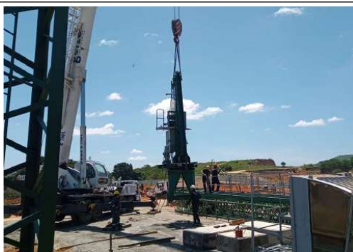
EXECUÇÃO MONTAGEM DA GRUA
