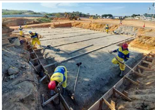
EXECUÇÃO DE ESTRUTURAS
