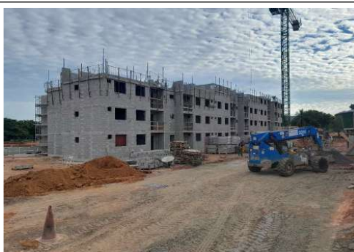
EXECUÇÃO DE ESTRUTURAS
