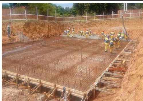
EXECUÇÃO DE ESTRUTURAS
