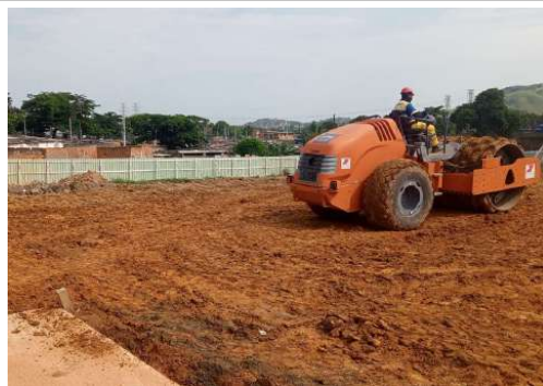
EXECUÇÃO DE REPARO NO SOLO
