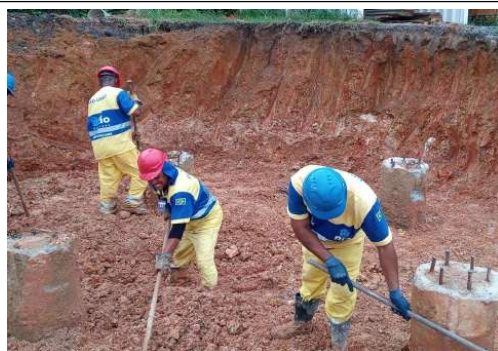
EXECUÇÃO DE FUNDAÇÃO DA GRUA
