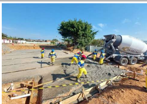
EXECUÇÃO DE ESTRUTURAS
