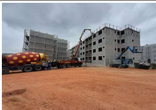
EXECUÇÃO DE ESTRUTURAS
