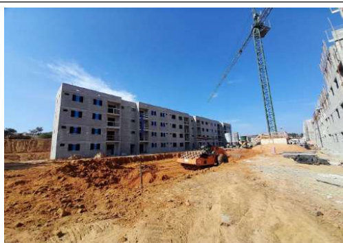
EXECUÇÃO DE ESTRUTURAS
