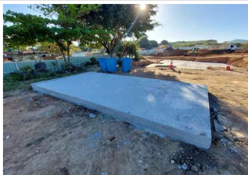
EXECUÇÃO DE BASE DOS SILOS DE ARGAMASSA
