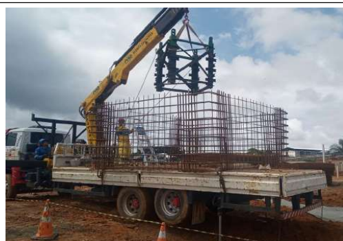
EXECUÇÃO DE FUNDAÇÃO DA GRUA
