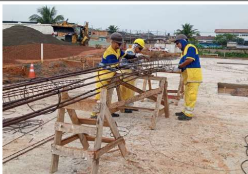
EXECUÇÃO DE FUNDAÇÃO DA GRUA
