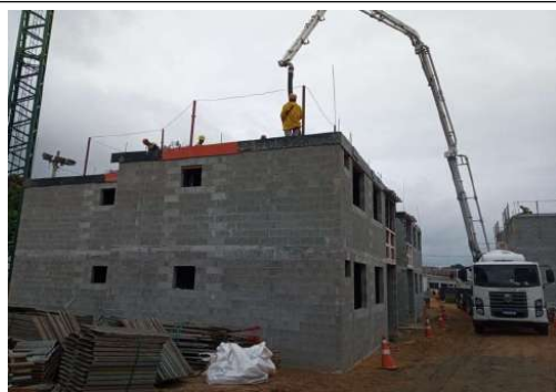
EXECUÇÃO DE ESTRUTURAS
