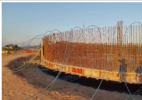
EXECUÇÃO DO RESERVATÓRIO
