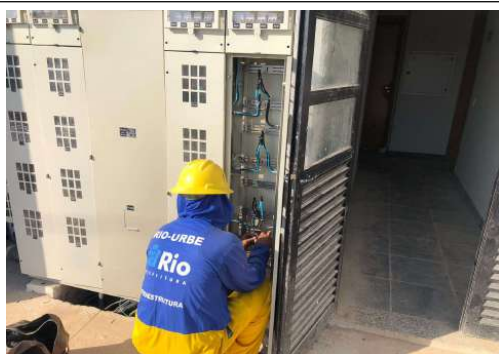
EXECUÇÃO DE INSTALAÇÕES
