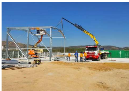
CANTEIRO PRINCIPAL - GALPÃO METÁLICO
