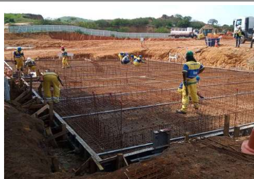
EXECUÇÃO DE ESTRUTURAS
