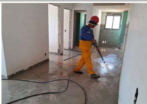
EXECUÇÃO DE SERVIÇOS INTERNOS
