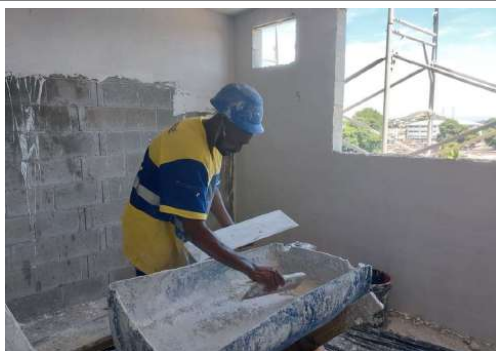
EXECUÇÃO DE REVESTIMENTO
