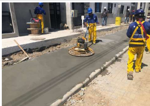
EXECUÇÃO DE SERVIÇOS EXTERNOS
