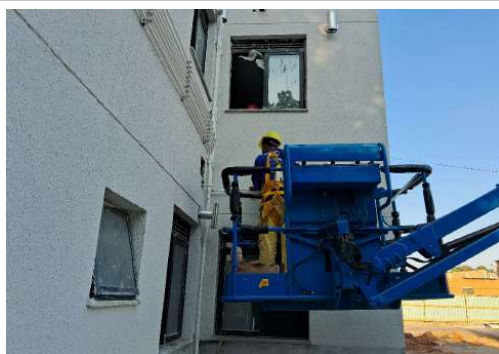
EXECUÇÃO DE SERVIÇOS INTERNOS
