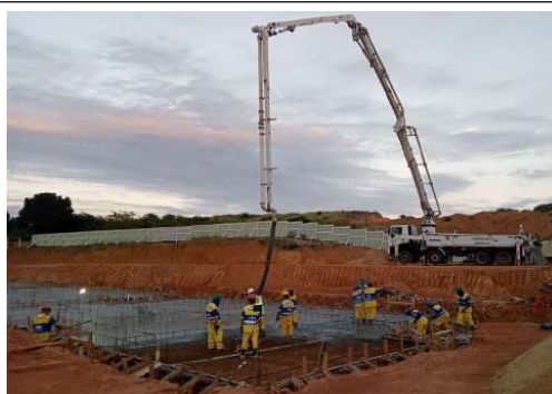
EXECUÇÃO DE ESTRUTURAS
