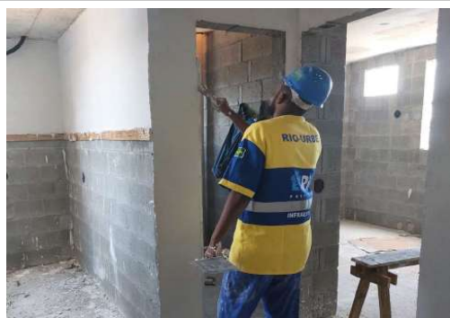
EXECUÇÃO DE REVESTIMENTO
