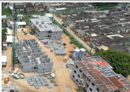
EXECUÇÃO DE ESTRUTURAS
