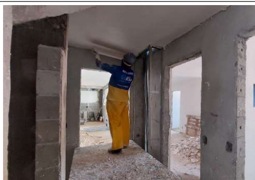
EXECUÇÃO DE REVESTIMENTO
