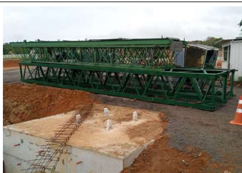
EXECUÇÃO MONTAGEM DA GRUA
