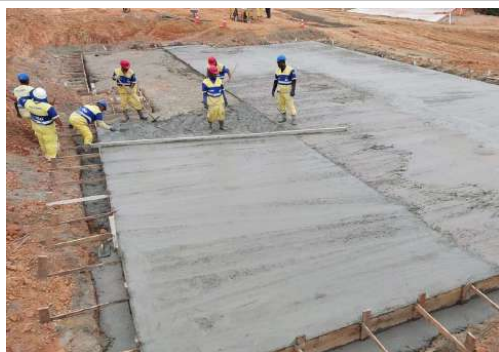
EXECUÇÃO DE ESTRUTURAS
