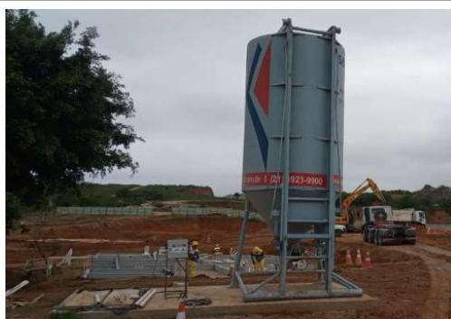
EXECUÇÃO DE BASE DOS SILOS DE ARGAMASSA
