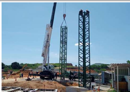
EXECUÇÃO MONTAGEM DA GRUA
