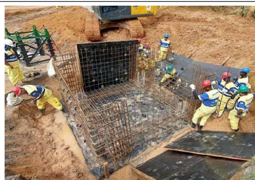
EXECUÇÃO DE FUNDAÇÃO DA GRUA
