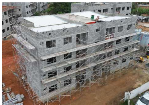
EXECUÇÃO DE ANDAIME
