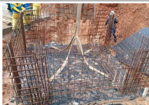
EXECUÇÃO DE FUNDAÇÃO DA GRUA
