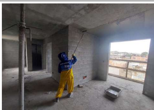
EXECUÇÃO DE REVESTIMENTO
