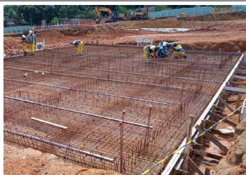
EXECUÇÃO DE ESTRUTURAS
