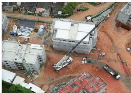
DESMOBILIZAÇÃO E MOBILIZAÇÃO DE GRUA
