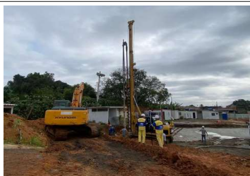
EXECUÇÃO DE FUNDAÇÃO DA GRUA
