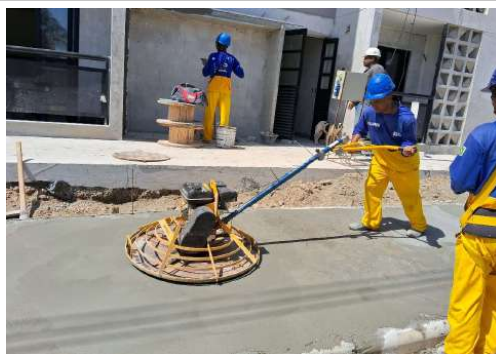
EXECUÇÃO DE SERVIÇOS EXTERNOS
