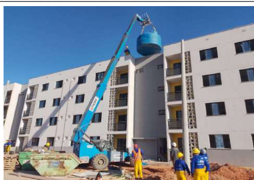
EXECUÇÃO DE SERVIÇOS EXTERNOS
