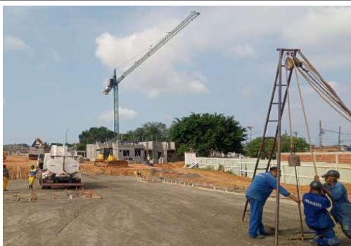
EXECUÇÃO DE FUNDAÇÃO DA GRUA
