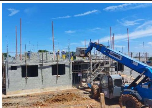
EXECUÇÃO DE ESTRUTURAS
