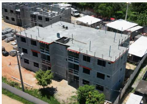
EXECUÇÃO DE ESTRUTURAS
