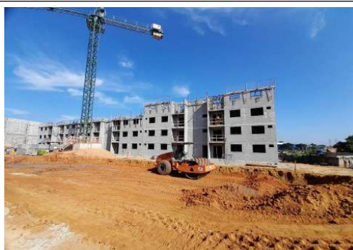
EXECUÇÃO DE ESTRUTURAS
