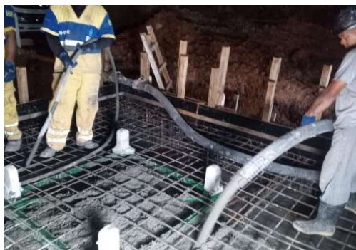
EXECUÇÃO DE FUNDAÇÃO DA GRUA
