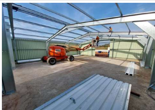
CANTEIRO PRINCIPAL - GALPÃO METÁLICO
