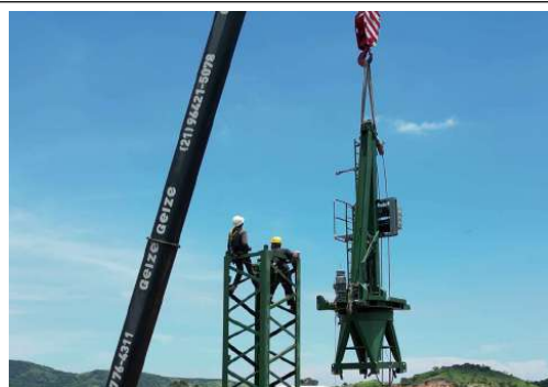
DESMOBILIZAÇÃO E MOBILIZAÇÃO DE GRUA
