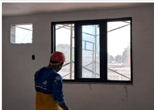
EXECUÇÃO DE REVESTIMENTO
