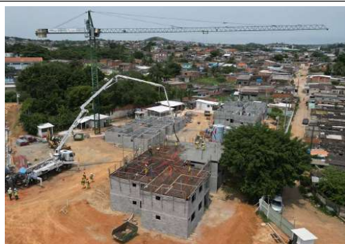
EXECUÇÃO DE ESTRUTURAS
