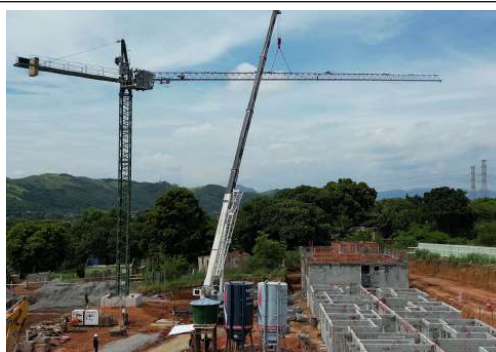
DESMOBILIZAÇÃO E MOBILIZAÇÃO DE GRUA
