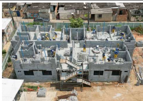
EXECUÇÃO DE ESTRUTURAS
