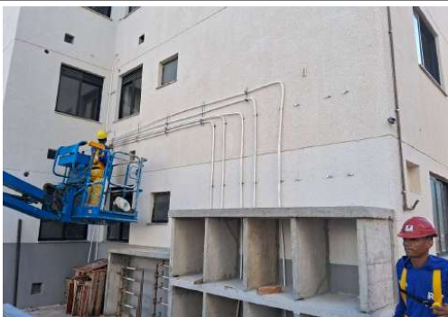
EXECUÇÃO DE INSTALAÇÕES
