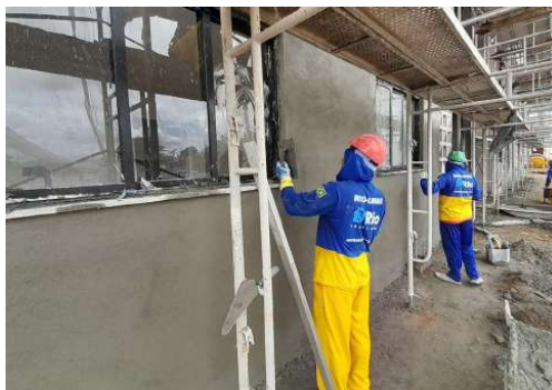
EXECUÇÃO DE REVESTIMENTO
