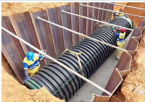
EXECUÇÃO DE REDE DE DRENAGEM
