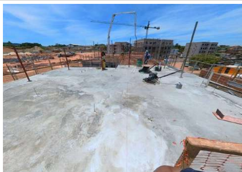
EXECUÇÃO DE ESTRUTURAS
