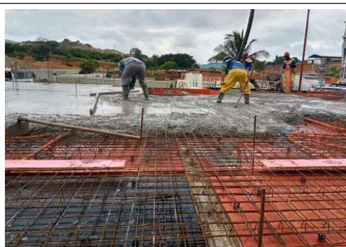
EXECUÇÃO DE ESTRUTURAS
