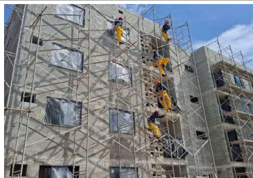
EXECUÇÃO DE ANDAIME
