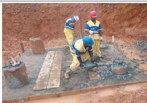
EXECUÇÃO DE FUNDAÇÃO DA GRUA
