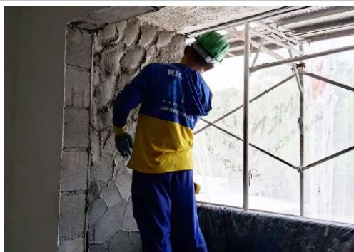
EXECUÇÃO DE REVESTIMENTO
