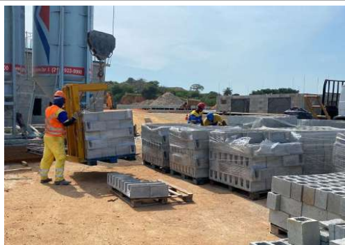
EXECUÇÃO DE ESTRUTURAS
