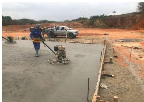
EXECUÇÃO DE SERVIÇOS EXTERNOS
