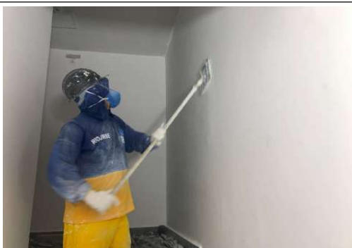
EXECUÇÃO DE REVESTIMENTO
