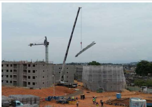
DESMOBILIZAÇÃO E MOBILIZAÇÃO DE GRUA
