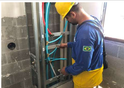
EXECUÇÃO DE INSTALAÇÕES
