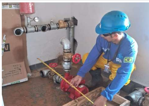
EXECUÇÃO DE INSTALAÇÕES
