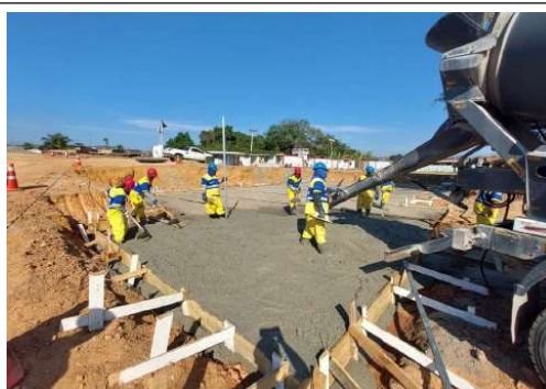
EXECUÇÃO DE ESTRUTURAS
