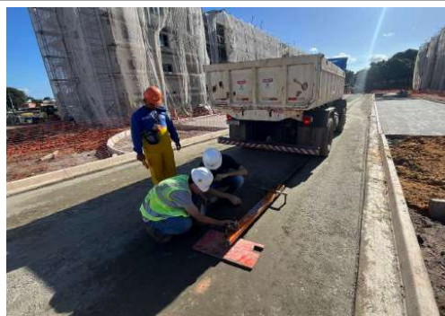
EXECUÇÃO DE URBANIZAÇÃO
