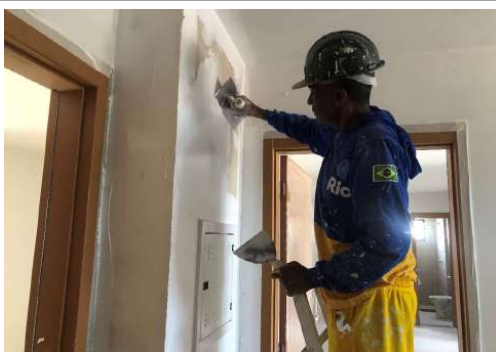
EXECUÇÃO DE REVESTIMENTO
