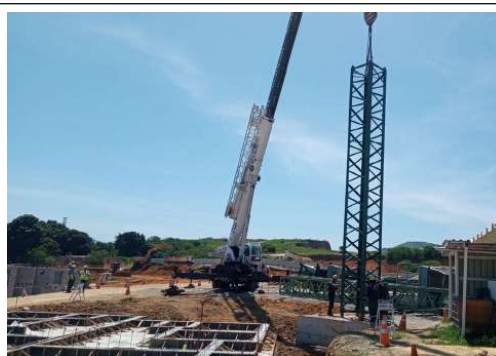
EXECUÇÃO MONTAGEM DA GRUA
