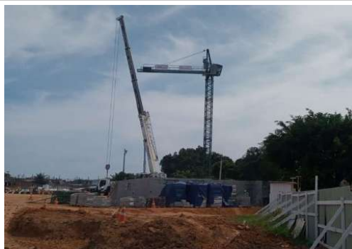
EXECUÇÃO MONTAGEM DA GRUA
