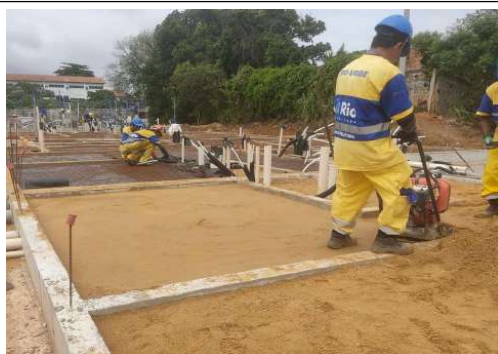
EXECUÇÃO DE ESTRUTURAS
