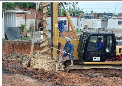
EXECUÇÃO DE FUNDAÇÃO DA GRUA
