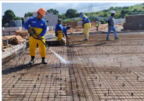
EXECUÇÃO DE ESTRUTURAS
