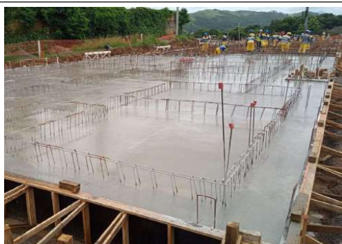
EXECUÇÃO DE ESTRUTURAS
