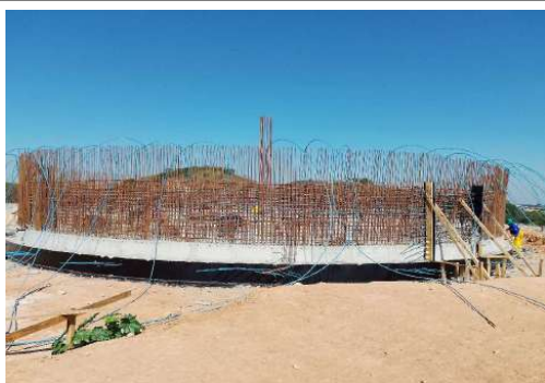
EXECUÇÃO DO RESERVATÓRIO
