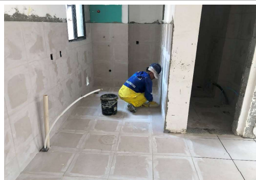
EXECUÇÃO DE SERVIÇOS INTERNOS
