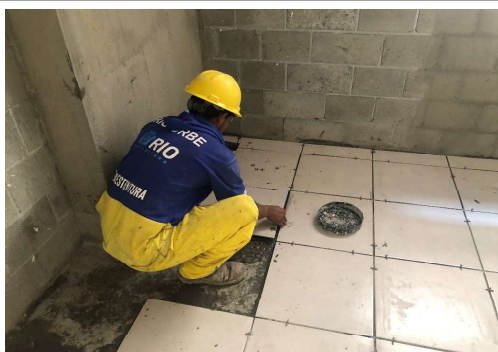
EXECUÇÃO DE SERVIÇOS INTERNOS
