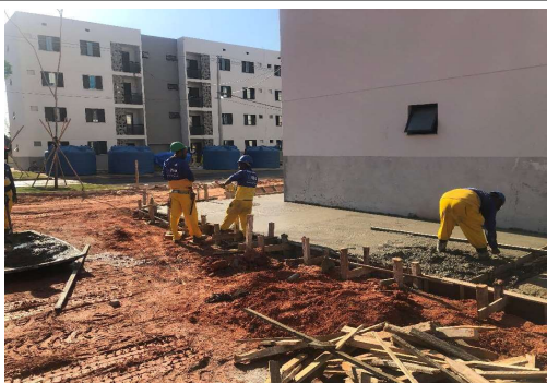
EXECUÇÃO DE ESTRUTURAS EM CONCRETO
