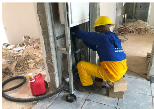
EXECUÇÃO DE SERVIÇOS INTERNOS
