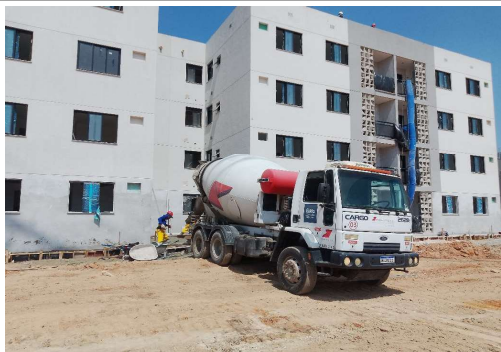
EXECUÇÃO DE ESTRUTURAS EM CONCRETO
