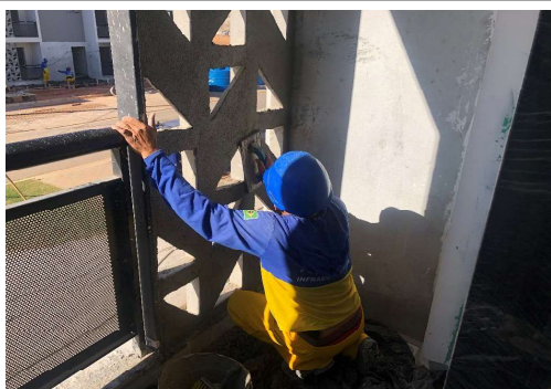
EXECUÇÃO DE SERVIÇOS INTERNOS
