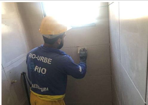
EXECUÇÃO DE SERVIÇOS INTERNOS
