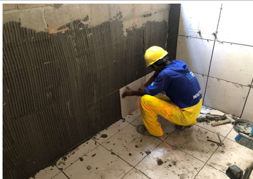
EXECUÇÃO DE SERVIÇOS INTERNOS
