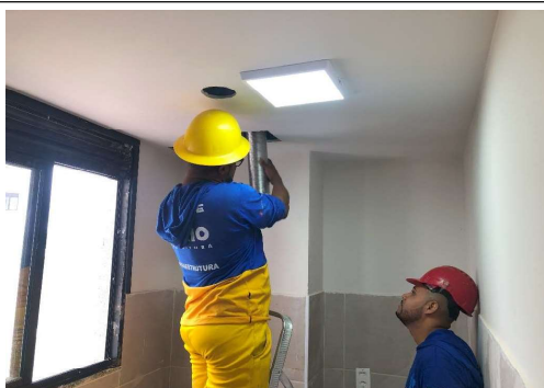
EXECUÇÃO DE SERVIÇOS INTERNOS
