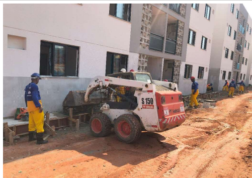
EXECUÇÃO DE ESTRUTURAS EM CONCRETO
