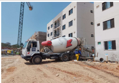
EXECUÇÃO DE ESTRUTURAS EM CONCRETO
