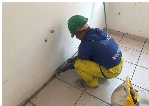
EXECUÇÃO DE SERVIÇOS INTERNOS
