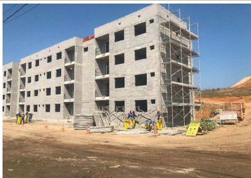
EXECUÇÃO DE ANDAIMES
