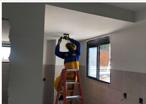
EXECUÇÃO DE SERVIÇOS INTERNOS
