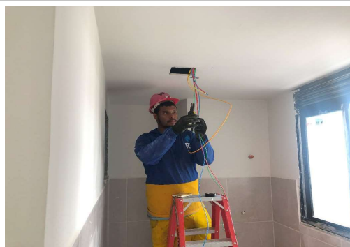
EXECUÇÃO DE SERVIÇOS INTERNOS
