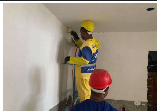
EXECUÇÃO DE SERVIÇOS INTERNOS
