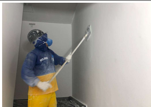
EXECUÇÃO DE SERVIÇOS INTERNOS
