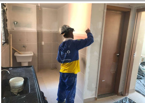
EXECUÇÃO DE SERVIÇOS INTERNOS
