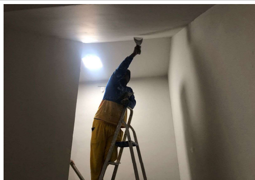
EXECUÇÃO DE SERVIÇOS INTERNOS
