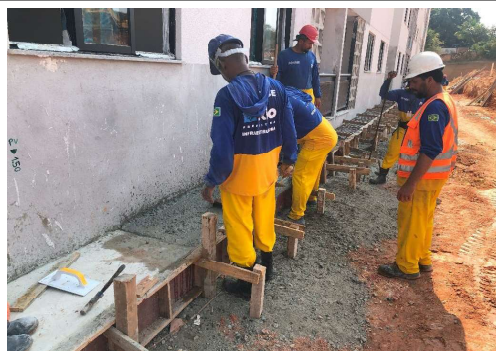
EXECUÇÃO DE ESTRUTURAS EM CONCRETO
