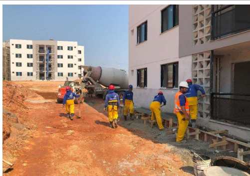
EXECUÇÃO DE ESTRUTURAS EM CONCRETO
