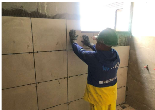
EXECUÇÃO DE SERVIÇOS INTERNOS
