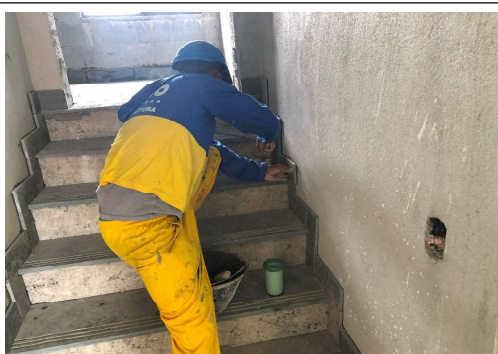
EXECUÇÃO DE SERVIÇOS INTERNOS
