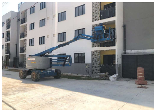
EXECUÇÃO DE SERVIÇOS EXTERNOS
