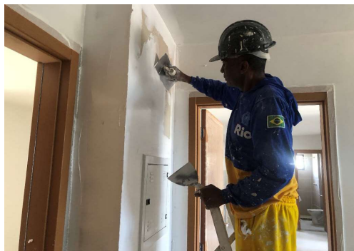
EXECUÇÃO DE SERVIÇOS INTERNOS
