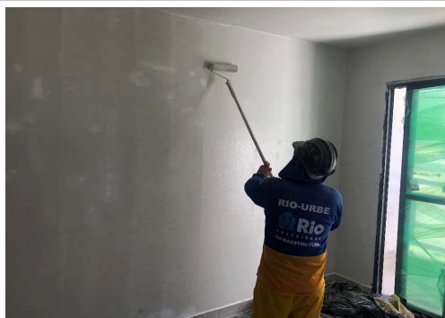
EXECUÇÃO DE SERVIÇOS INTERNOS
