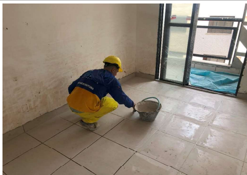
EXECUÇÃO DE SERVIÇOS INTERNOS
