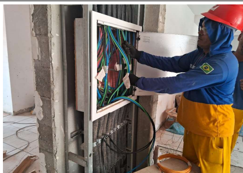
EXECUÇÃO DE SERVIÇOS INTERNOS
