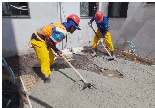
EXECUÇÃO DE ESTRUTURAS EM CONCRETO
