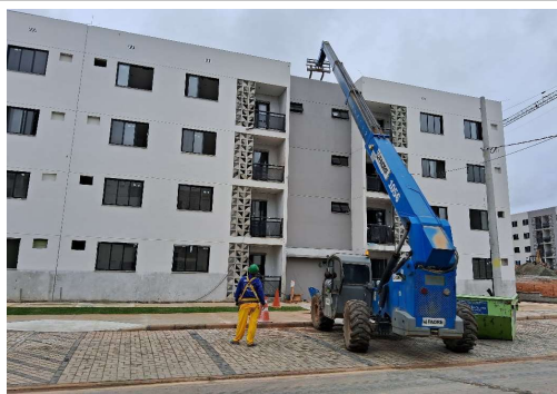
EXECUÇÃO DE SERVIÇOS EXTERNOS
