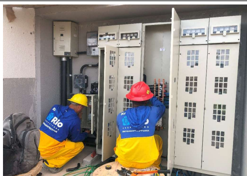
EXECUÇÃO DE SERVIÇOS INTERNOS
