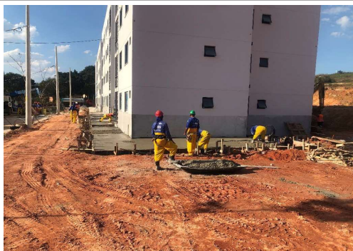
EXECUÇÃO DE ESTRUTURAS EM CONCRETO
