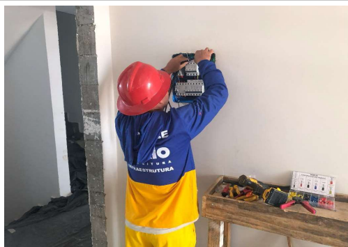
EXECUÇÃO DE SERVIÇOS INTERNOS
