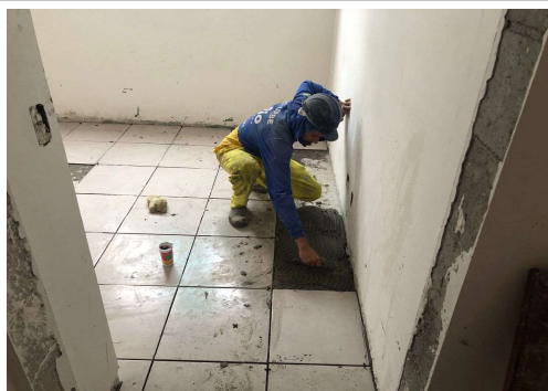
EXECUÇÃO DE SERVIÇOS INTERNOS
