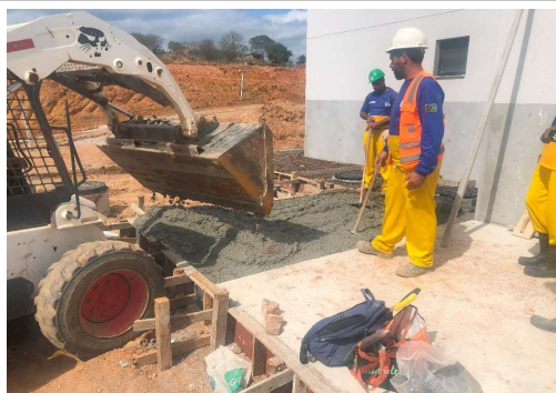
EXECUÇÃO DE ESTRUTURAS EM CONCRETO
