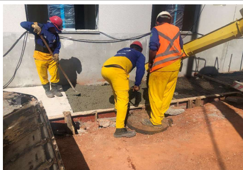
EXECUÇÃO DE ESTRUTURAS EM CONCRETO
