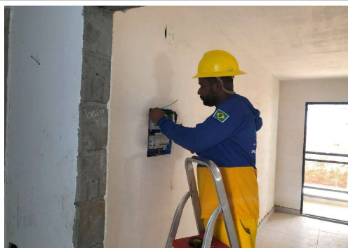
EXECUÇÃO DE SERVIÇOS INTERNOS
