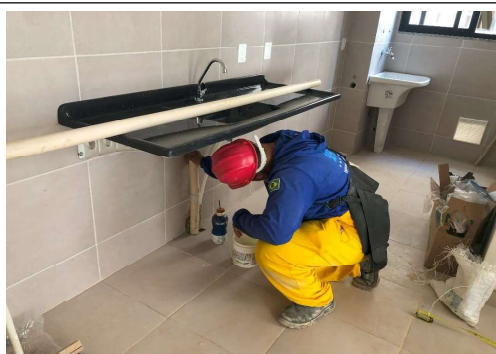
EXECUÇÃO DE SERVIÇOS INTERNOS
