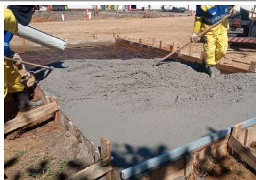
EXECUÇÃO DE BASE DOS SILOS DE ARGAMASSA
