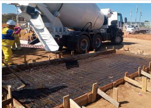
EXECUÇÃO DE BASE DOS SILOS DE ARGAMASSA
