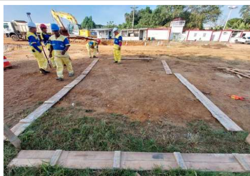
EXECUÇÃO DE BASE DOS SILOS DE ARGAMASSA
