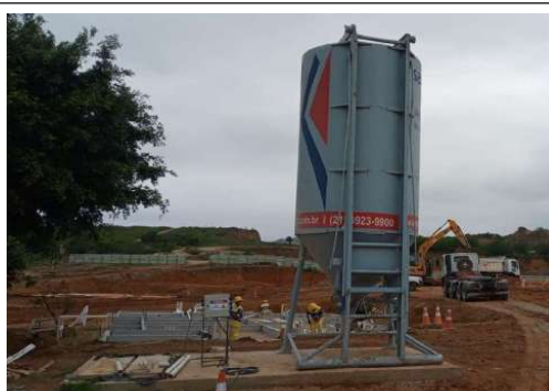
EXECUÇÃO DE BASE DOS SILOS DE ARGAMASSA
