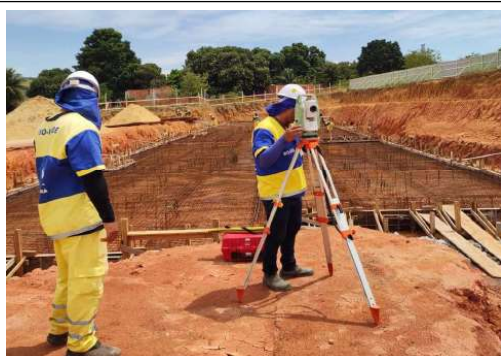
LEVANTAMENTO TOPOGRÁFICO
