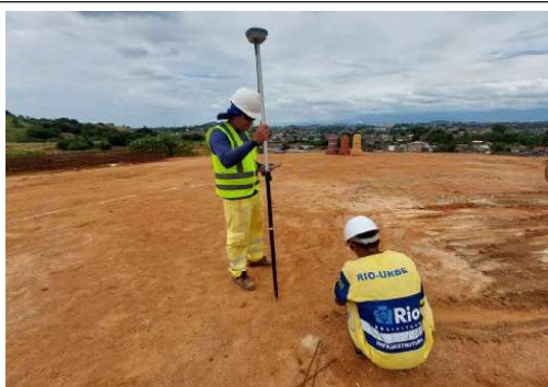
LEVANTAMENTO TOPOGRÁFICO
