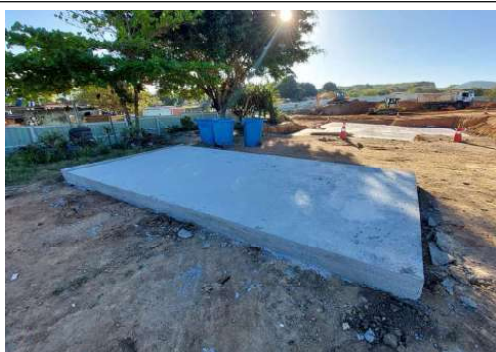
EXECUÇÃO DE BASE DOS SILOS DE ARGAMASSA
