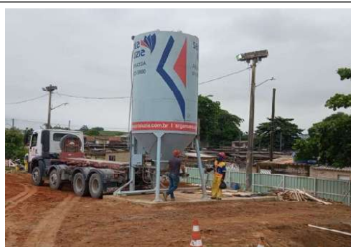
EXECUÇÃO DE BASE DOS SILOS DE ARGAMASSA
