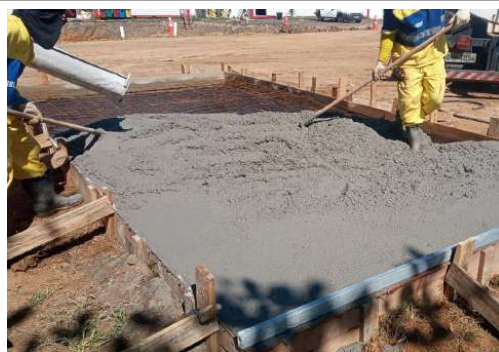
EXECUÇÃO DE BASE DOS SILOS DE ARGAMASSA
