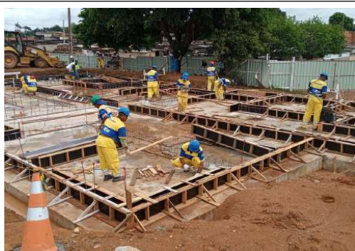
EXECUÇÃO DE ESTRUTURAS
