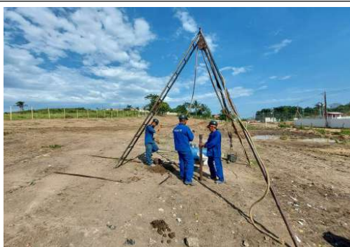
EXECUÇÃO DE SONDAGEM
