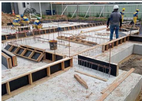
EXECUÇÃO DE ESTRUTURAS
