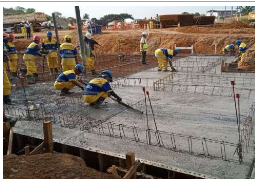
EXECUÇÃO DE ESTRUTURAS
