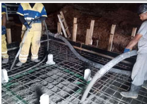
EXECUÇÃO DE FUNDAÇÃO DA GRUA
