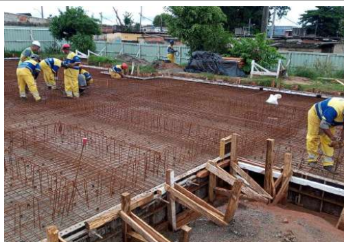
EXECUÇÃO DE ESTRUTURAS
