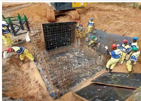
EXECUÇÃO DE FUNDAÇÃO DA GRUA
