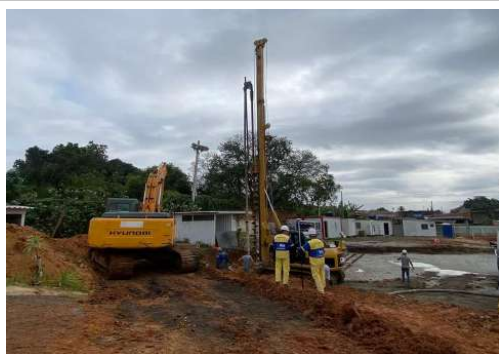
EXECUÇÃO DE FUNDAÇÃO DA GRUA
