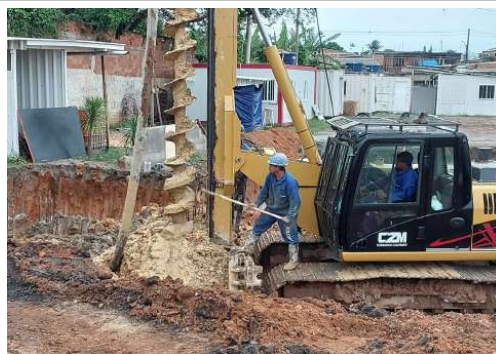
EXECUÇÃO DE FUNDAÇÃO DA GRUA
