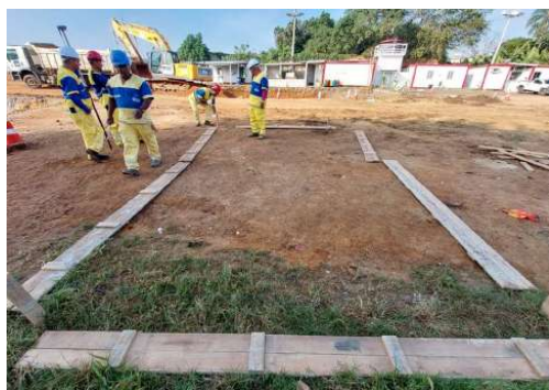
EXECUÇÃO DE BASE DOS SILOS DE ARGAMASSA
