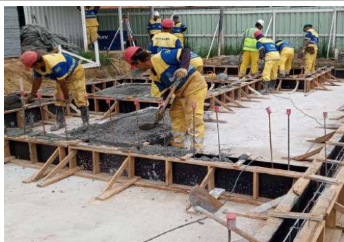
EXECUÇÃO DE ESTRUTURAS
