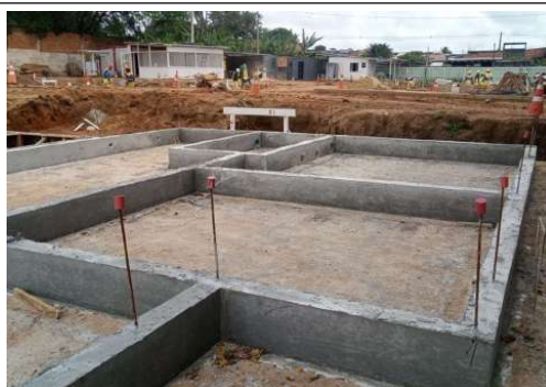
EXECUÇÃO DE ESTRUTURAS
