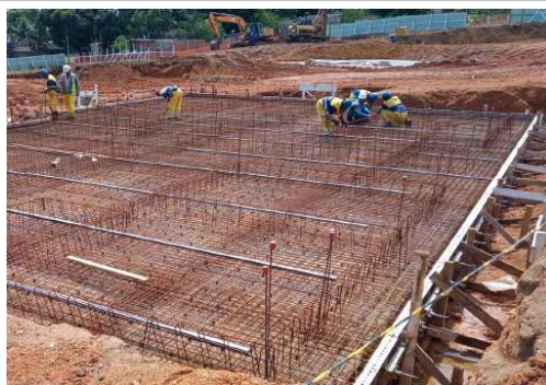
EXECUÇÃO DE ESTRUTURAS
