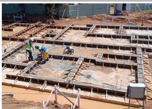
EXECUÇÃO DE ESTRUTURAS
