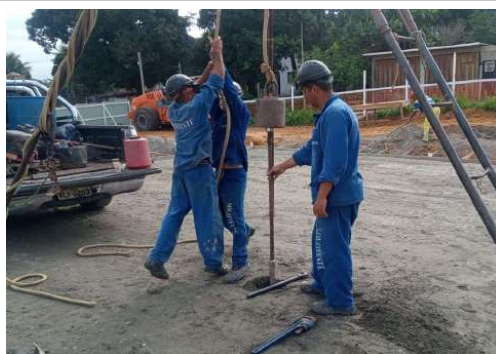
EXECUÇÃO DE SONDAGEM
