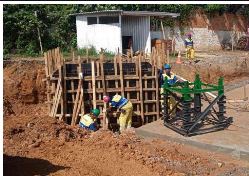
EXECUÇÃO DE FUNDAÇÃO DA GRUA
