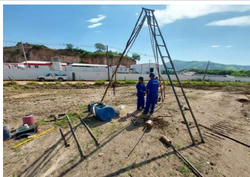
EXECUÇÃO DE SONDAGEM
