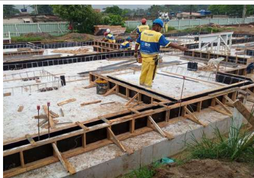
EXECUÇÃO DE ESTRUTURAS
