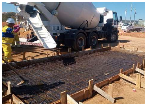
EXECUÇÃO DE BASE DOS SILOS DE ARGAMASSA
