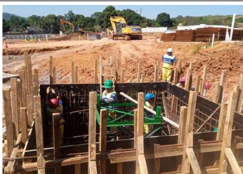
EXECUÇÃO DE FUNDAÇÃO DA GRUA
