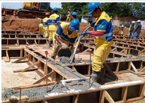
EXECUÇÃO DE ESTRUTURAS
