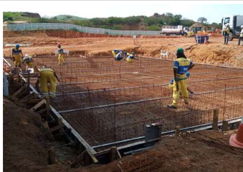
EXECUÇÃO DE ESTRUTURAS
