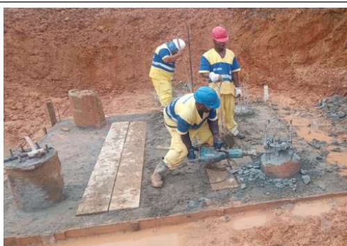
EXECUÇÃO DE FUNDAÇÃO DA GRUA
