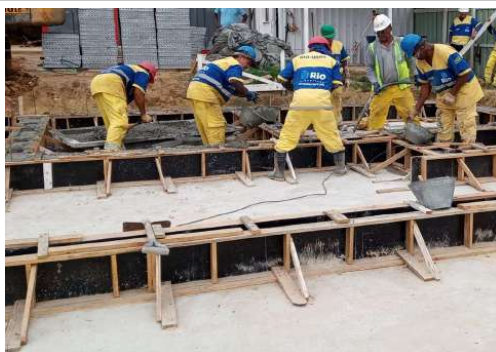
EXECUÇÃO DE ESTRUTURAS
