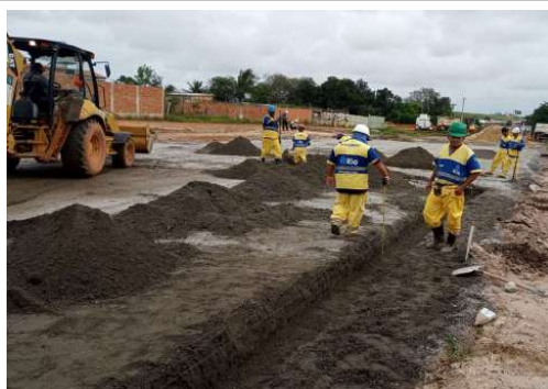
EXECUÇÃO DE ESTRUTURAS
