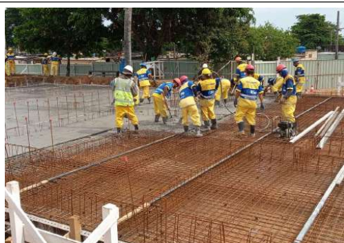
EXECUÇÃO DE ESTRUTURAS
