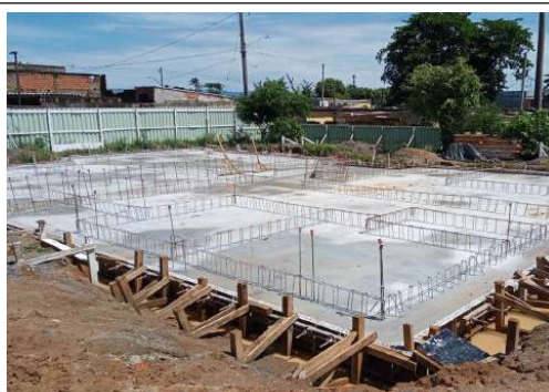
EXECUÇÃO DE ESTRUTURAS
