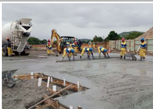
EXECUÇÃO DE ESTRUTURAS
