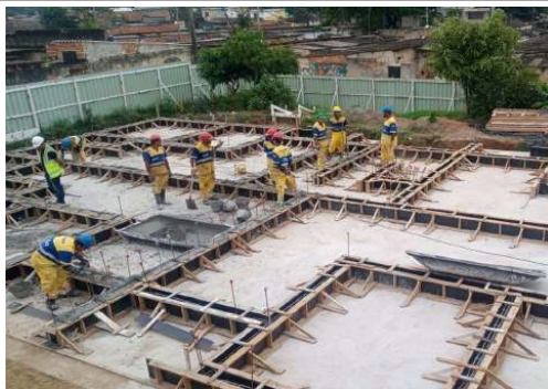
EXECUÇÃO DE ESTRUTURAS
