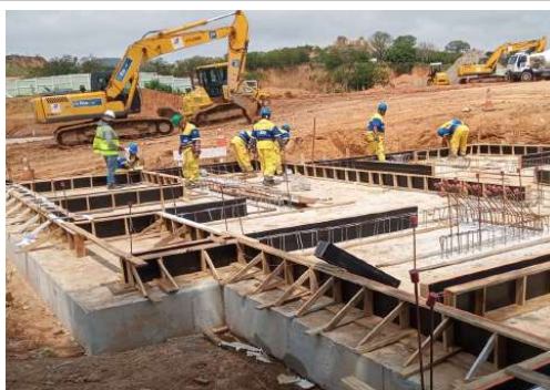
EXECUÇÃO DE ESTRUTURAS
