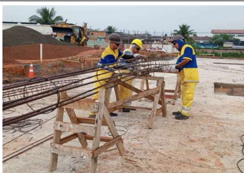
EXECUÇÃO DE FUNDAÇÃO DA GRUA
