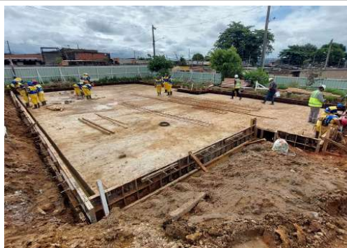
EXECUÇÃO DE ESTRUTURAS
