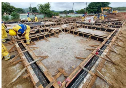
EXECUÇÃO DE ESTRUTURAS
