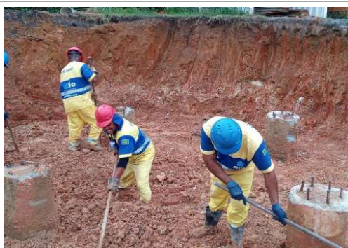
EXECUÇÃO DE FUNDAÇÃO DA GRUA
