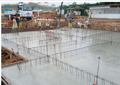
EXECUÇÃO DE ESTRUTURAS
