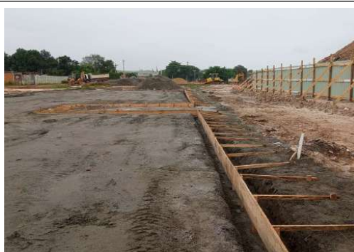
EXECUÇÃO DE ESTRUTURAS
