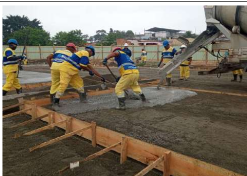
EXECUÇÃO DE ESTRUTURAS
