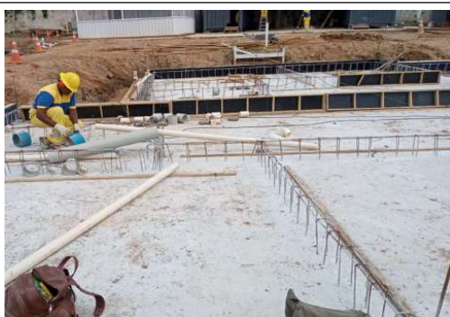
EXECUÇÃO DE ESTRUTURAS
