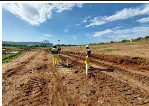
EXECUÇÃO DE SONDAGEM
