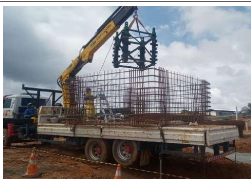
EXECUÇÃO DE FUNDAÇÃO DA GRUA
