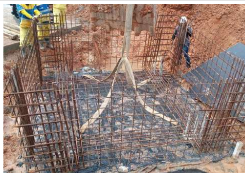
EXECUÇÃO DE FUNDAÇÃO DA GRUA
