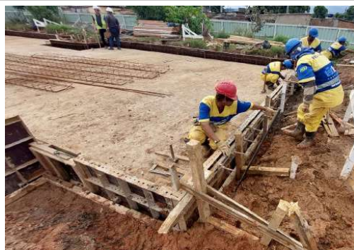
EXECUÇÃO DE ESTRUTURAS
