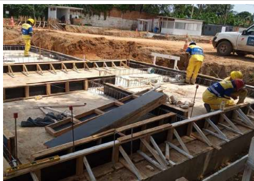
EXECUÇÃO DE ESTRUTURAS
