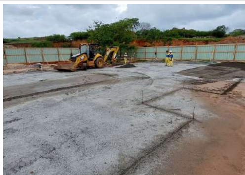
EXECUÇÃO DE ESTRUTURAS
