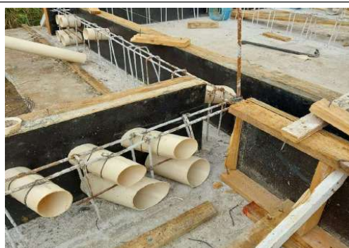
EXECUÇÃO DE ESTRUTURAS
