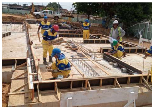
EXECUÇÃO DE ESTRUTURAS
