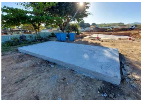
EXECUÇÃO DE BASE DOS SILOS DE ARGAMASSA
