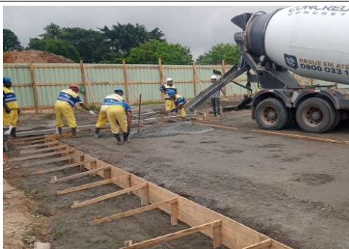
EXECUÇÃO DE ESTRUTURAS
