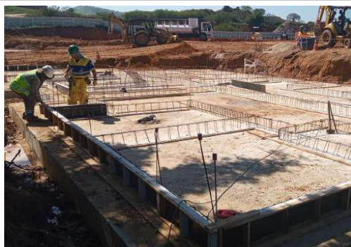
EXECUÇÃO DE ESTRUTURAS
