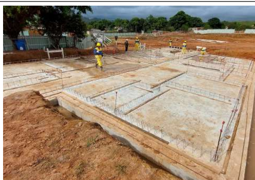
EXECUÇÃO DE ESTRUTURAS
