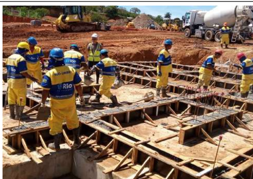
EXECUÇÃO DE ESTRUTURAS
