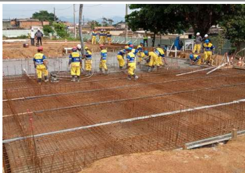
EXECUÇÃO DE ESTRUTURAS
