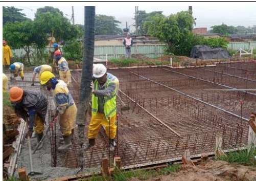
EXECUÇÃO DE ESTRUTURAS
