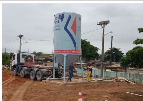
EXECUÇÃO DE BASE DOS SILOS DE ARGAMASSA
