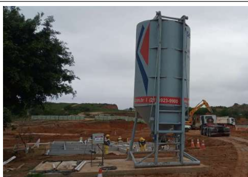
EXECUÇÃO DE BASE DOS SILOS DE ARGAMASSA
