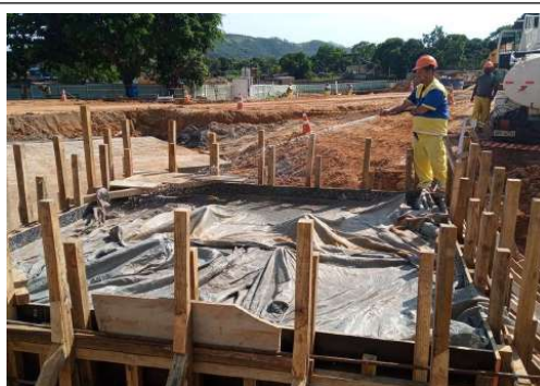
EXECUÇÃO DE FUNDAÇÃO DA GRUA
