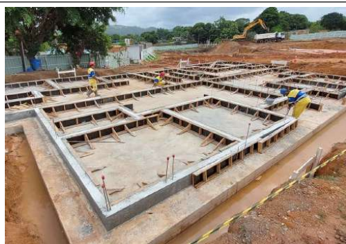
EXECUÇÃO DE ESTRUTURAS
