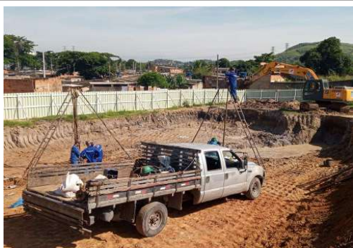
EXECUÇÃO DE SONDAGEM
