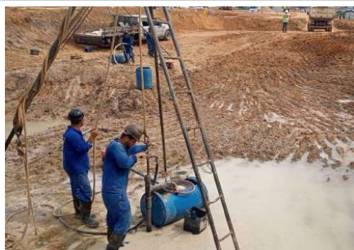
EXECUÇÃO DE SONDAGEM
