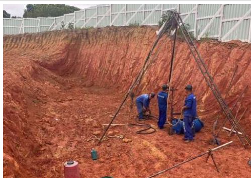
EXECUÇÃO DE SONDAGEM
