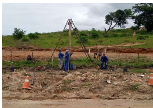
EXECUÇÃO DE SONDAGEM
