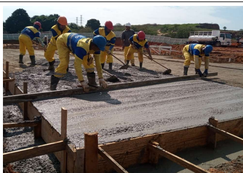
EXECUÇÃO DE ESTRUTURAS
