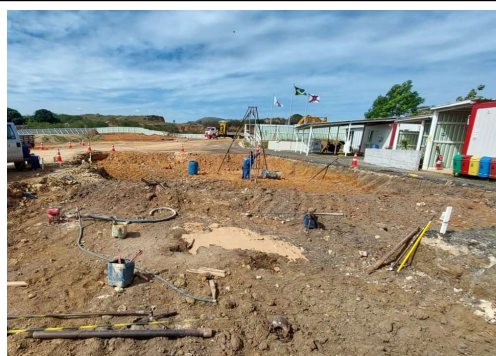
EXECUÇÃO DE SONDAAGEM
