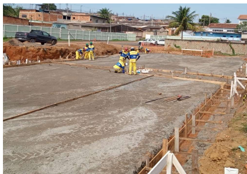
EXECUÇÃO DE ESTRUTURAS
