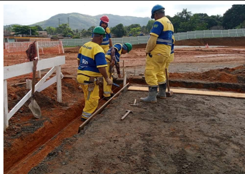
EXECUÇÃO DE ESTRUTURAS
