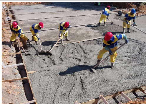
EXECUÇÃO DE ESTRUTURAS
