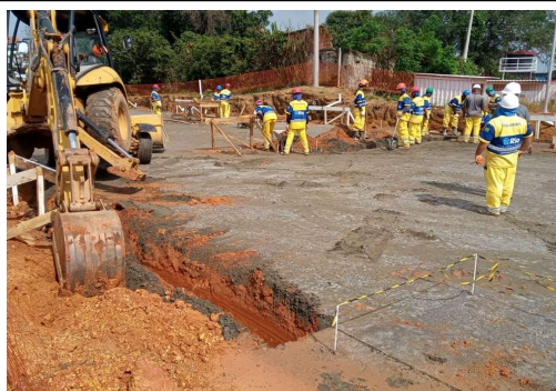
EXECUÇÃO DE ESTRUTURAS
