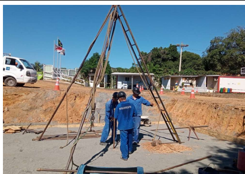
EXECUÇÃO DE SONDAAGEM
