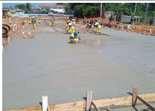
EXECUÇÃO DE ESTRUTURAS
