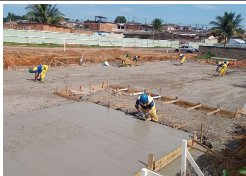
EXECUÇÃO DE ESTRUTURAS
