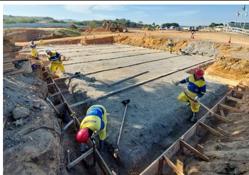
EXECUÇÃO DE ESTRUTURAS
