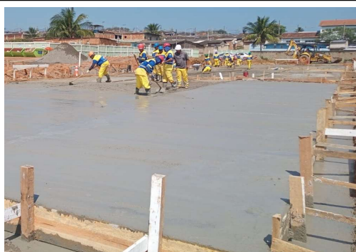
EXECUÇÃO DE ESTRUTURAS
