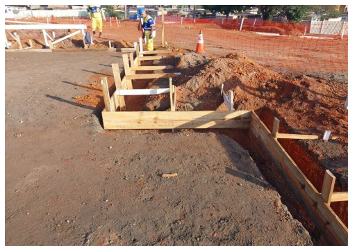
EXECUÇÃO DE ESTRUTURAS
