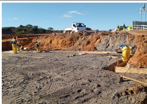
EXECUÇÃO DE ESTRUTURAS
