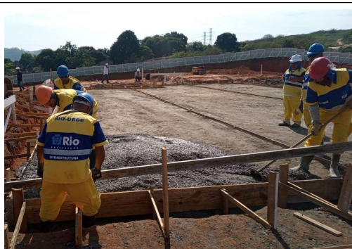
EXECUÇÃO DE ESTRUTURAS
