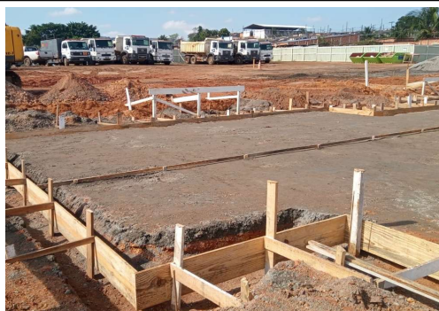
EXECUÇÃO DE ESTRUTURAS
