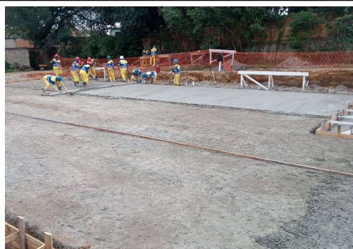
EXECUÇÃO DE ESTRUTURAS
