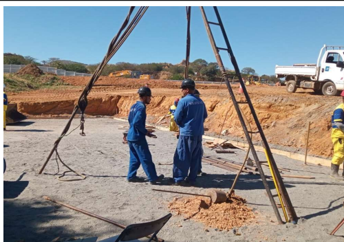
EXECUÇÃO DE SONDAAGEM
