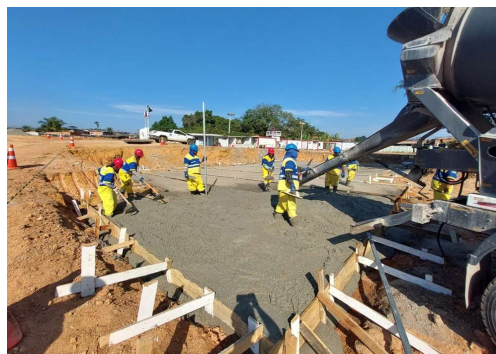
EXECUÇÃO DE ESTRUTURAS
