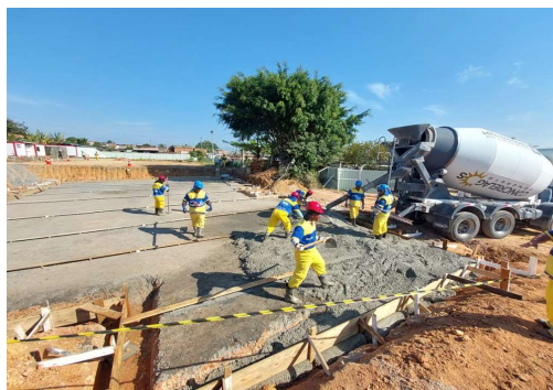
EXECUÇÃO DE ESTRUTURAS
