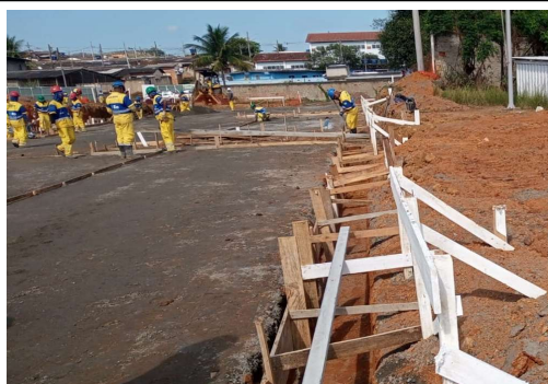
EXECUÇÃO DE ESTRUTURAS
