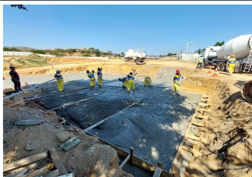
EXECUÇÃO DE ESTRUTURAS
