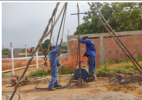
EXECUÇÃO DE SONDAAGEM
