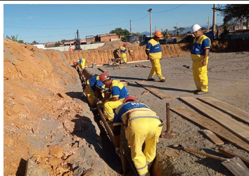
EXECUÇÃO DE ESTRUTURAS
