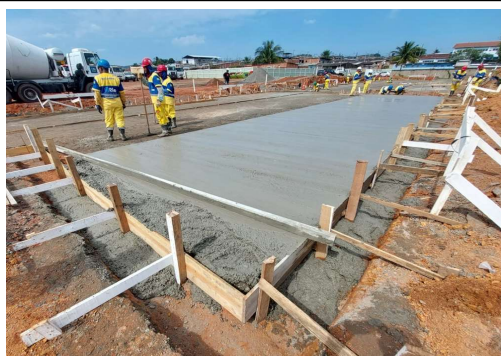
EXECUÇÃO DE ESTRUTURAS
