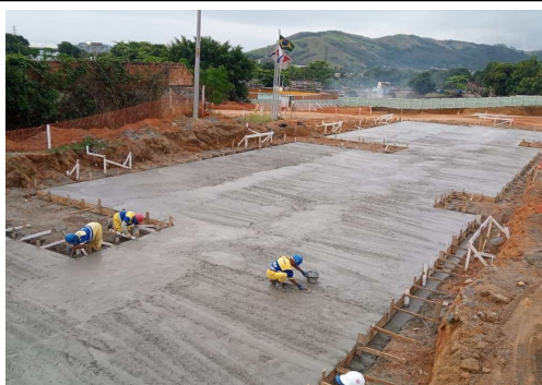
EXECUÇÃO DE ESTRUTURAS
