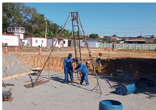
EXECUÇÃO DE SONDAGEM
