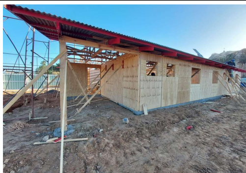
CANTEIRO PRINCIPAL - ESTRUTURA DE MADEIRA
