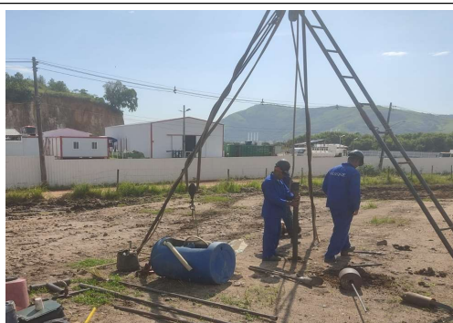
EXECUÇÃO DE SONDAGEM
