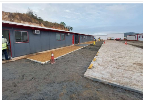
CANTEIRO PRINCIPAL - PAVIMENTAÇÃO
